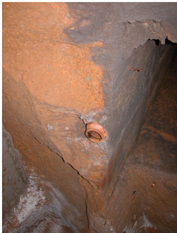
Fig. 4. Tubo di terracotta nella volta di una cavità sotterranea esplorata nel sottosuolo dell'area oggetto di studio utilizzata come serbatoio di acqua piovana (foto Varriale R.).
