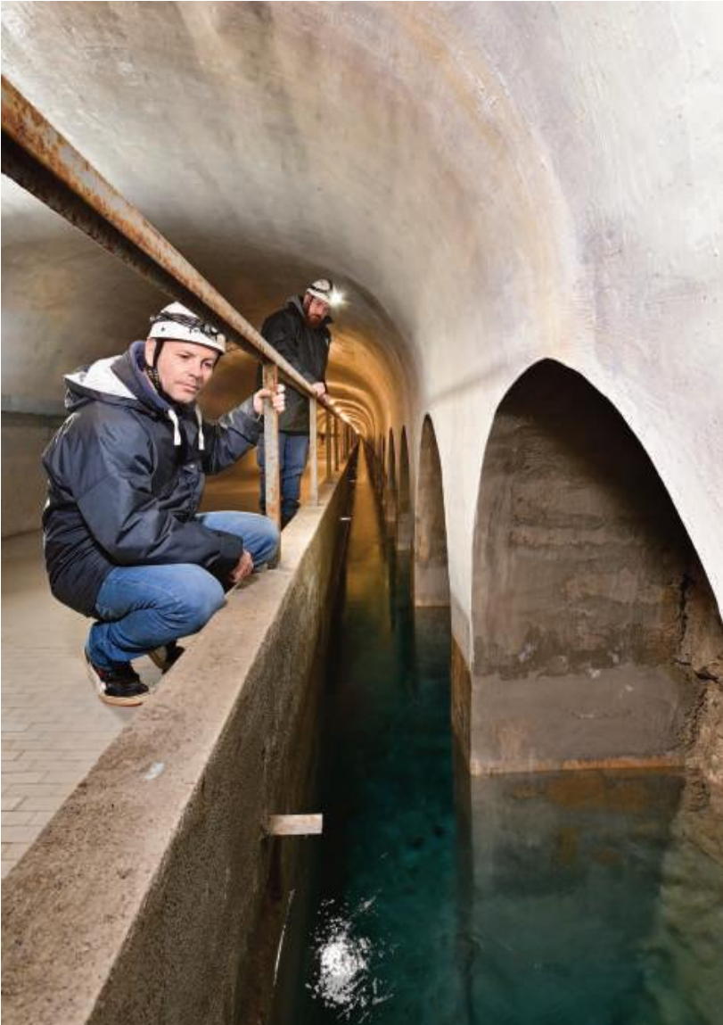
Fig. 19. Galleria drenante le sorgenti Rio Freddo (foto N. Paolantonio). Tunnel draining the Rio Freddo springs (ph. N. Paolantonio).
