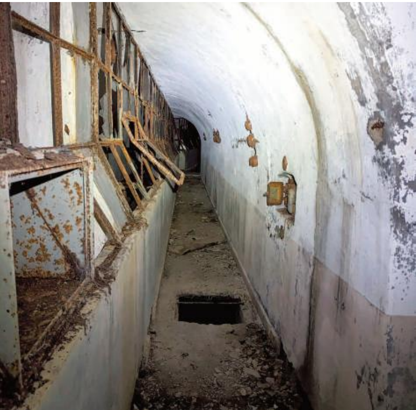
Fig. 20. Vecchie gallerie drenanti le sorgenti Rio Freddo (foto P. Di Ludovico). Old tunnels draining the Rio Freddo springs (ph. P. Di Ludovico).
