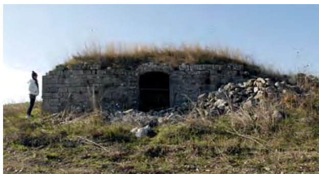
Fig. 18a – Tipologia di neviera seminterrata / Neviera Colabella, Bonefro (CB) (tipologia A9e) (foto M. Mancini).
