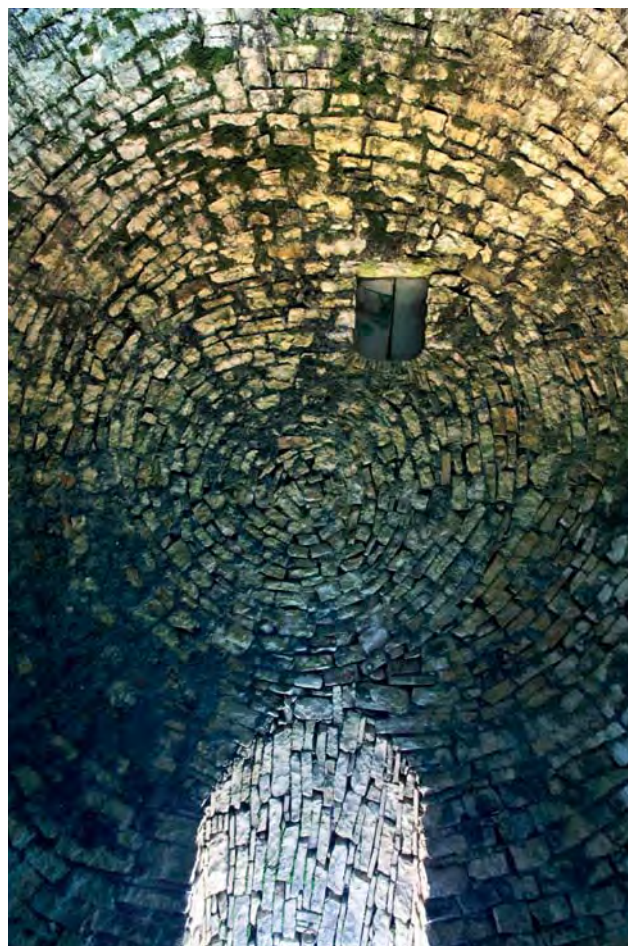
Fig. 1 – Dettaglio delle tecniche costruttive della volta e dell'ingresso di una neviere in agro di Bonefro (CB / Molise) (foto N. Paolantonio).
