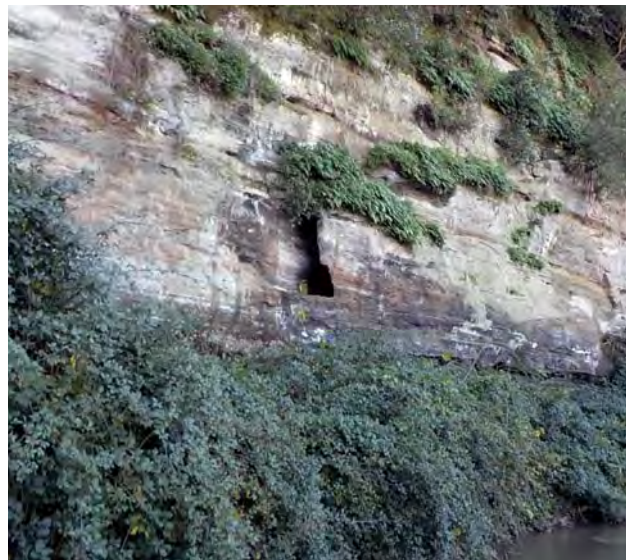
Fig. 5 – Esempio di galleria scavata allo scopo di deviare un flusso d'acqua, non più funzionale dopo l'abbassamento del letto del torrente (fosso della Mola di Formello, Roma) (foto T. Dobosz).
