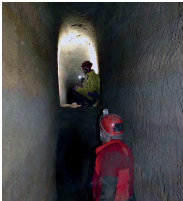
Fig. 3 – Anche le opere di captazione destinate ad alimentare semplici fontanili possono presentarsi con strutture composite. Captazioni che alimentavano i fontanili di Villa Grazioli (Grottaferrata, Roma) (foto C. Germani).
