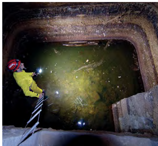
Fig. 7 – Cisterna di Latina (Latina), struttura di accumulo acque meteoriche sotto la Torre Frangipane (foto C. Germani).
