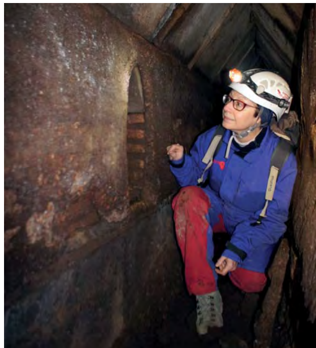
Fig. 4 – Specus con tipica volta a cappuccina nell'acquedotto Facciate di Nemi (o acquedotto di Egeria), Nemi (Roma) (foto M. Vitelli, ASSO).
