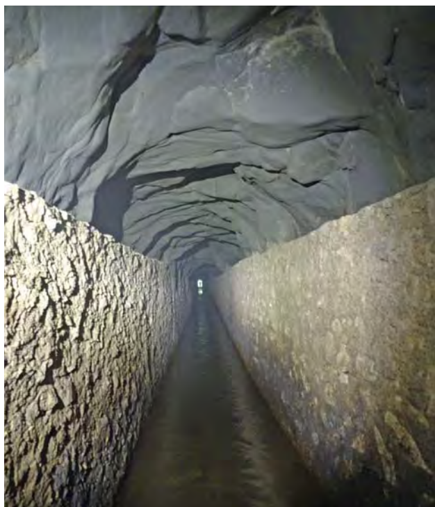
Fig. 34 – Il tunnel con la volta di marne e arenarie fini (foto Anna Pedicone Cioffi).
