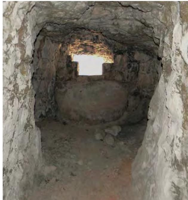
Fig. 10 – Feritoia con banchina di tiro in Eb, complesso C1 (foto F. Bassani).
