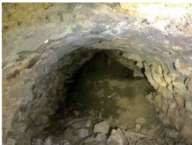
Fig. 9 – Tratto dello speco del Marcio nei pressi del Punto B, visto in direzione nord. Si noti la copertura a spioventi (foto A. Schatzmann).
