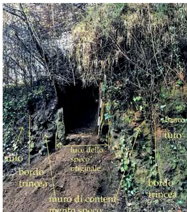
Fig. 18 – La struttura dello speco nel Punto D (foto ed elaborazione grafica A. Schatzmann).
