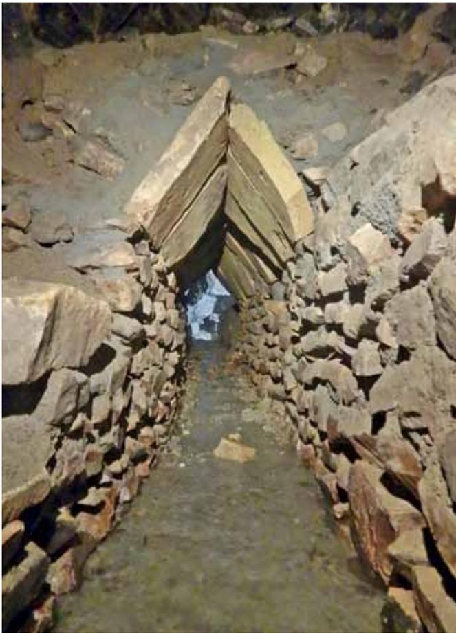
Fig. 13 – Buso della Casara: condotto voltato “alla cappuccina” lungo il collettore principale (settore orientale). Le tavelle in cotto e parte della struttura laterale appaiono consolidate in tempi recenti (foto D. Davolio).
