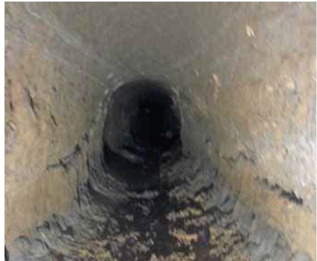
Fig. 22 – Vista del breve e rettilineo cunicolo *bypass* dal fondo del pozzo P2, scavato parallelo alla galleria di carriaggio di Colle Selva (Galliciano nel Lazio - Roma).
