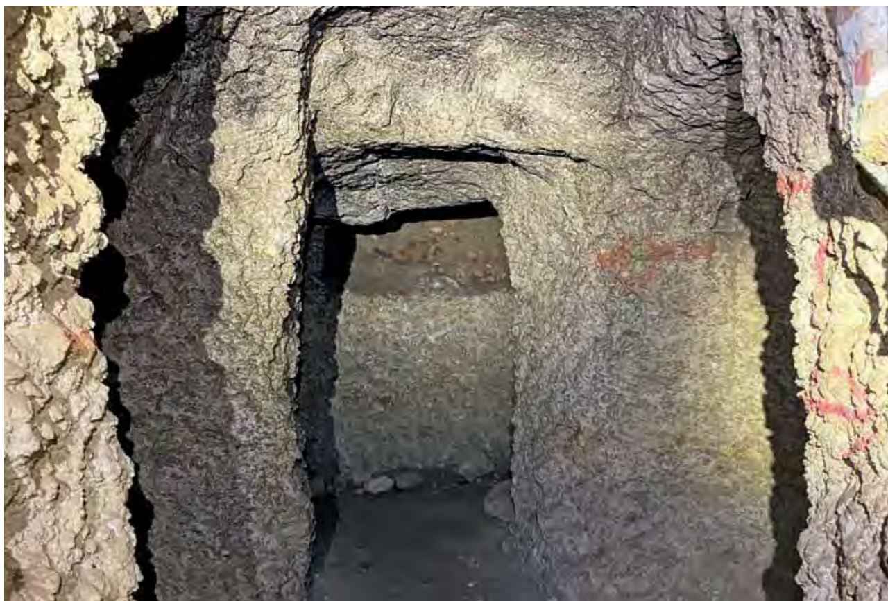
Fig. 13 – Acquedotto di Rodi: gallerie per la distribuzione delle acque sotto il centro storico della città (foto E. P. Diakatos A.)
