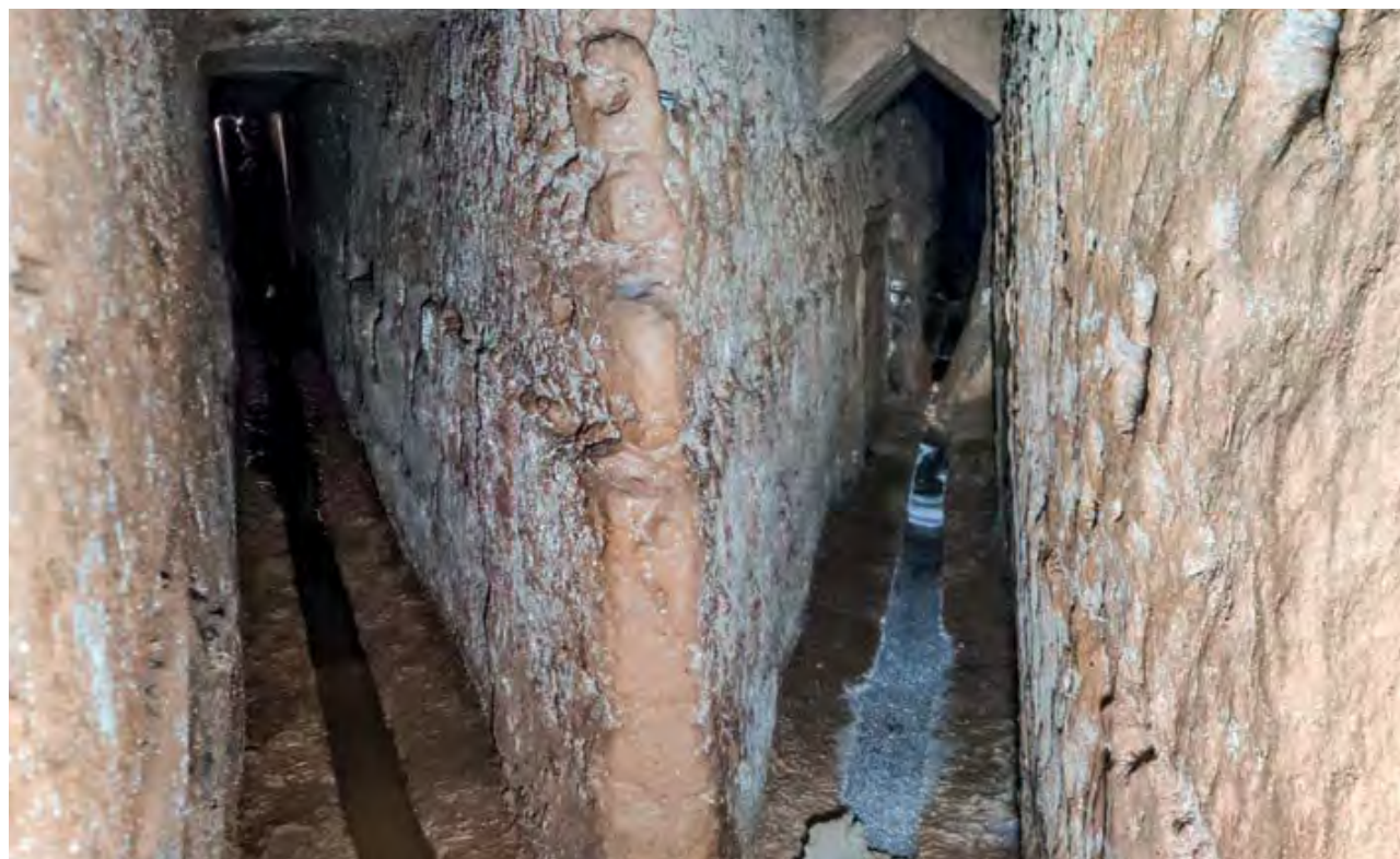
Fig. 10 – Acquedotto di Krana: tipologie di sezioni predominanti (foto Michele Magnoni).
