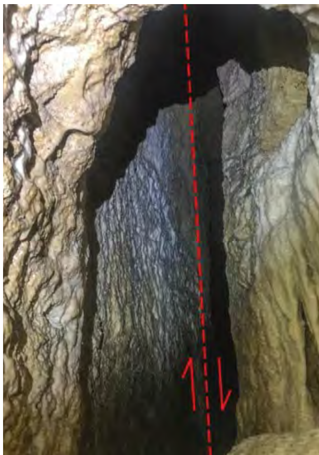
Fig. 4 – Acquedotto di Livada: tratto di galleria che si sviluppa in corrispondenza della faglia. La linea rossa evidenzia la faglia e le frecce indicano le direzioni di scorrimento delle due superfici (foto E. P. Diakatos Arvanitis).
