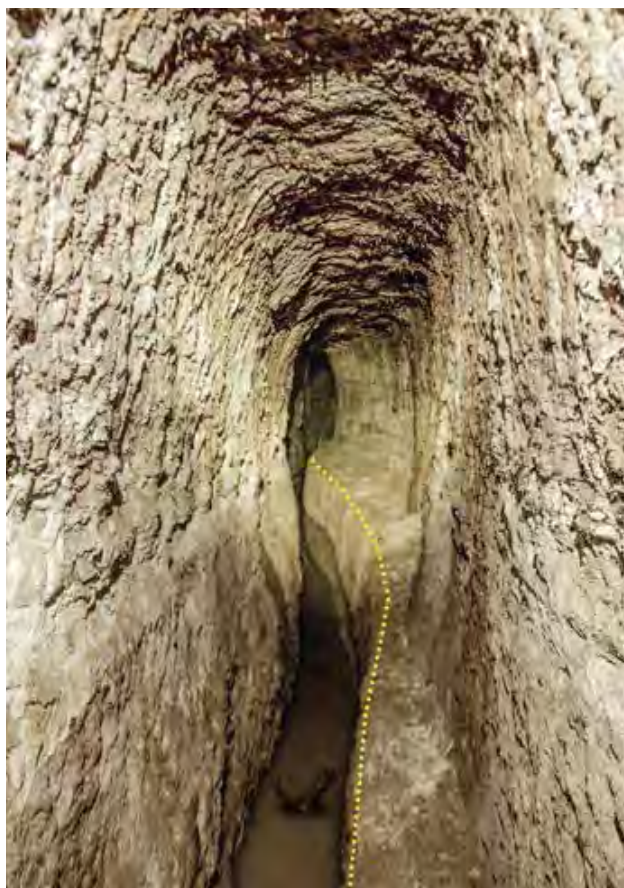
Fig. 5 – Acquedotto di Livada: sezione approfondita durante la dominazione Italiana. La linea gialla puntinata evidenzia la porzione di galleria approfondita (foto E. P. Diakatos Arvanitis).
