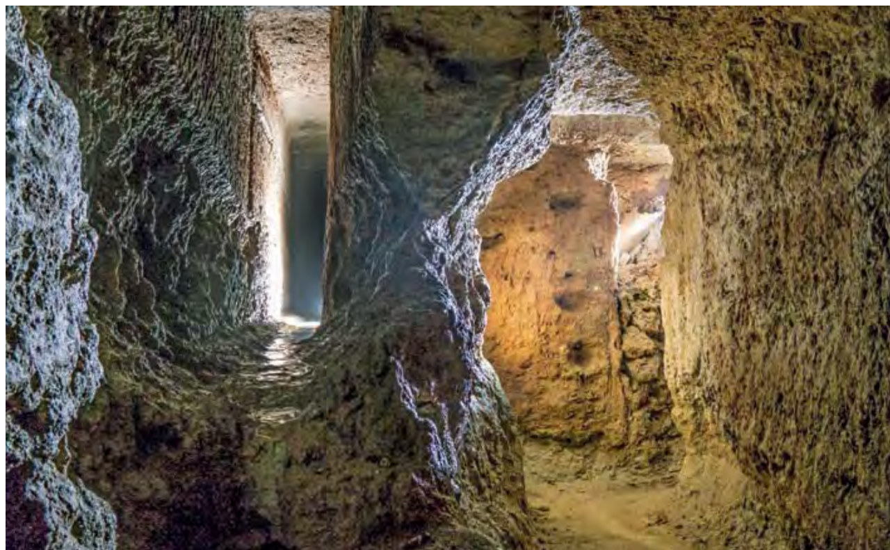
Fig. 9 – Acquedotto di Krana: crocevia. Nelle gallerie è ben evidente l'erosione operata dal deflusso delle acque sulla formazione geologica (foto Michele Magnoni).
