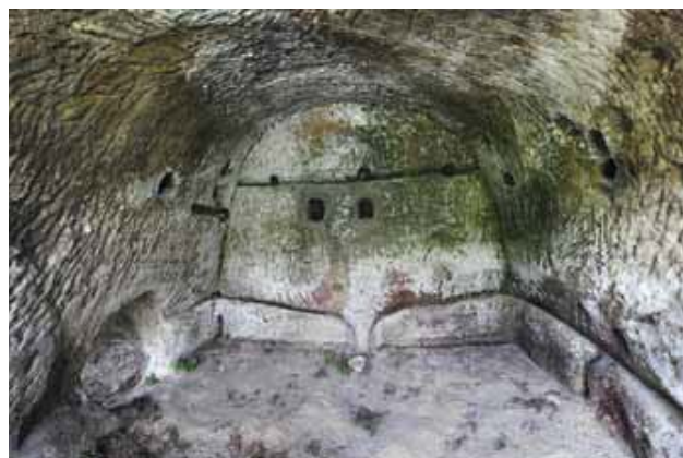
Fig. 11 – Veduta interna del tratto medio-terminale della cavità n. 18, ubicata sul secondo livello altitudinale: si notino i solchi alla base delle pareti e i numerosi fori per l'inserimento di travi e pali in legno (foto di F. Larocca).
