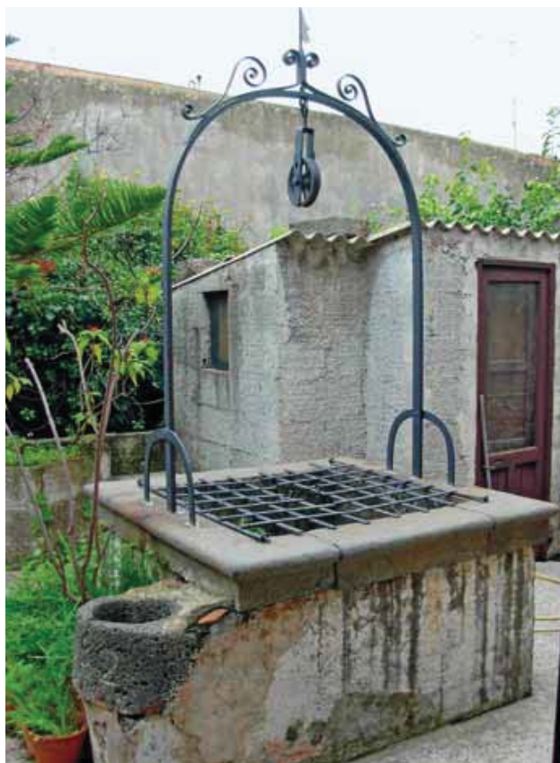
Fig. 8 – Il pozzo della cisterna (foto A. Cariola).
