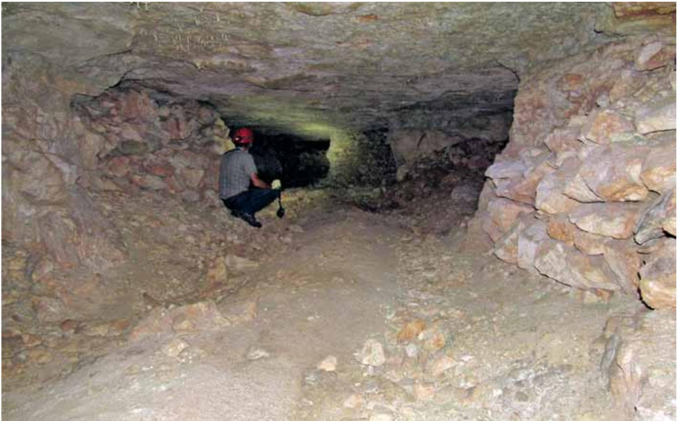
Fig. 5 – A sinistra sfrido di materiali accumulati in modo caotico, a destra muro a secco per il contenimento del materiale (foto L. Arena).
