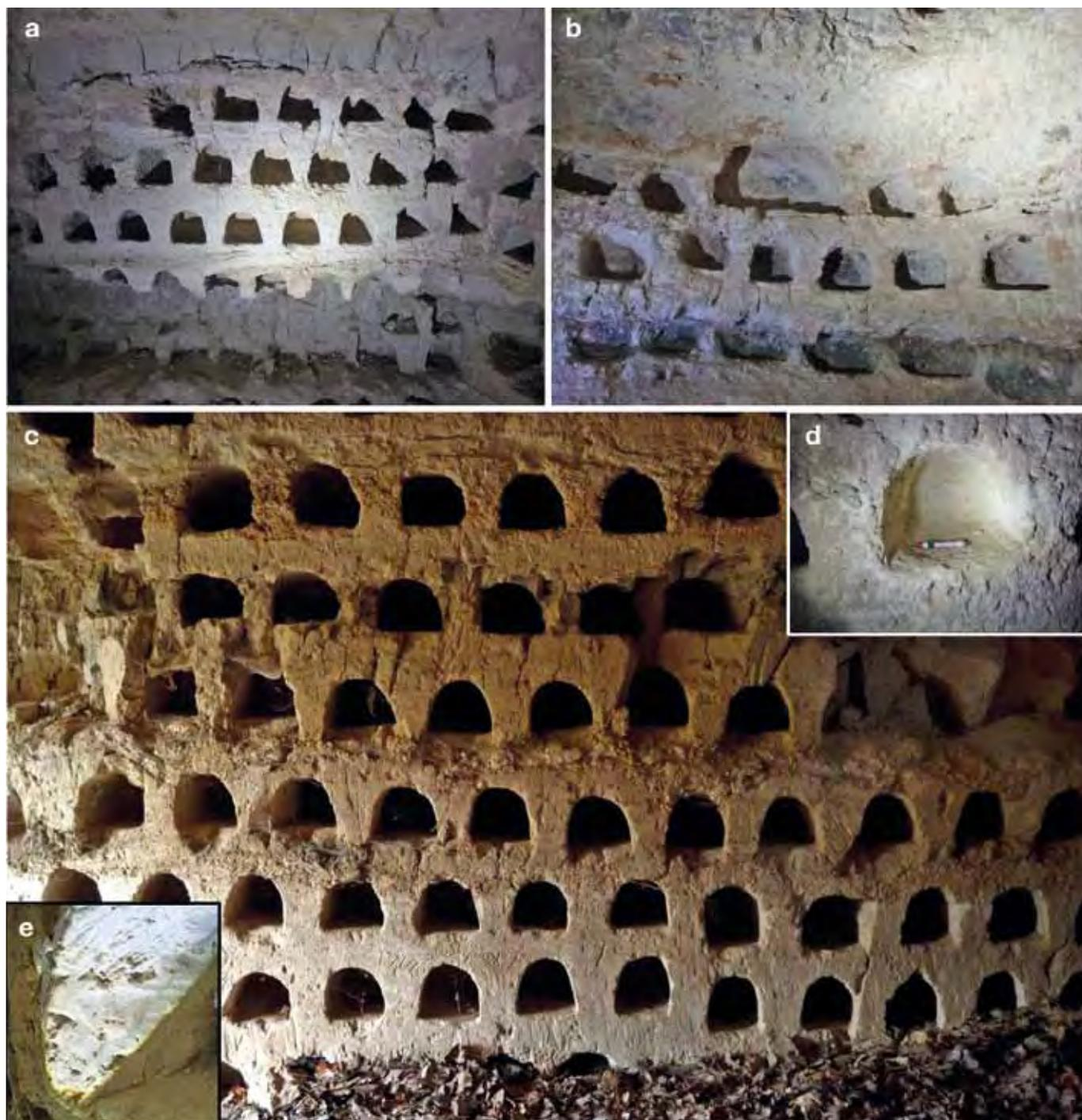
Fig. 3 – Fotografie rappresentative delle nicchie presenti all’interno degli ipogei: (a), (b), (c) evidenziano rispettivamente l’allineamento sfalsato, regolare o allineamento misto; (d) mostra le dimensioni delle nicchie; (e) intonacatura interna delle nicchie rinvenute nel sito di Castelrinaldi (archivio Gruppo Speleologico UTEC Narni).
