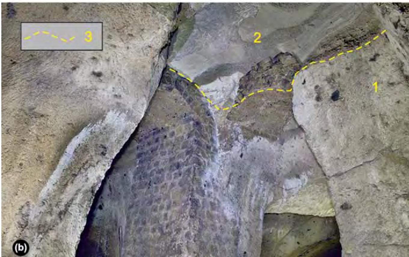
Fig. 4 – Esempi di: (a) volta ricostruita; (b) volta ricostruita ed in seguito crollata: 1) tufo, 2) depositi piroclastici da caduta, 3) contatto stratigrafico (foto M. Vigliotti).
