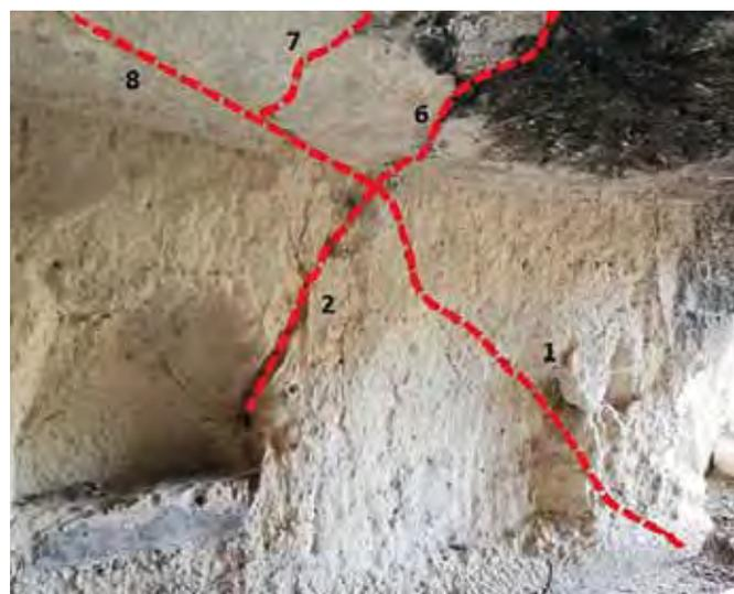
Fig. 7 – Dettaglio di una parete all'interno della cavità n. 76, con in evidenza alcuni dei sistemi di discontinuità individuati (foto e grafica A. Gioia).
