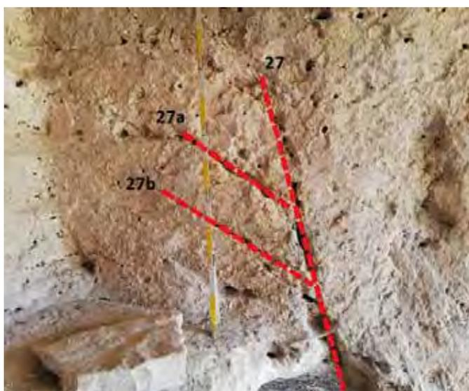
Fig. 4 – Sistemi di discontinuità nell'ammasso calcarenitico in parete (foto e grafica A. Gioia).
