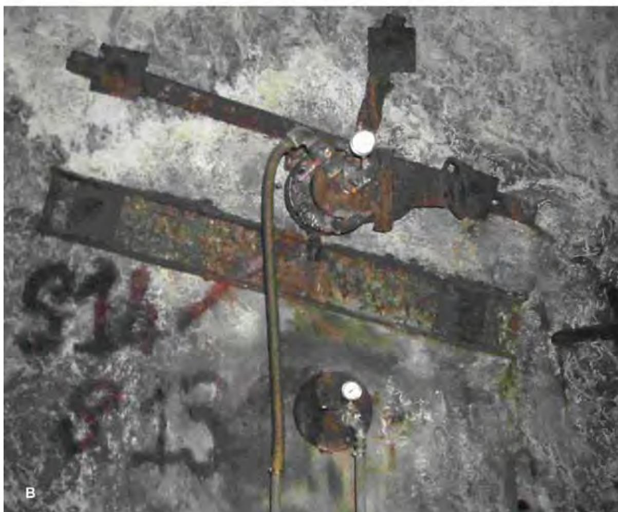
Fig. 6 – A: Indagini geognostiche (Catalano e Salsa, 2003) dei sei sondaggi presenti nella “camera dei drenaggi” (in rosso) localizzata vicino l’uscita dai LNGS; B: nella foto sono visibili le “teste” dei sondaggi orizzontali S13 ed S14 (foto G. De Luca).
