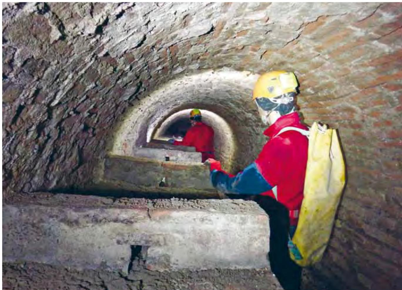
Fig. 3 – Il condotto verso la Fontana del Nettuno (1563) . Sulla sinistra è visibile il muro su cui era alloggiato il tubo per l'alimentazione della fontana (foto R. Simonetti).
