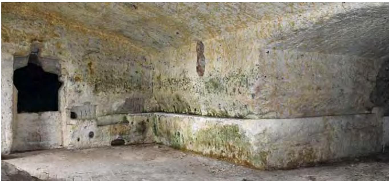
Fig. 5 – Neviera Vigoriti presso la chiesa della Madonna dell'Abbondanza. Si può notare a sinistra la porta di accesso della neviere collegata, mediante canaletta ricavata nella parete, alla cisterna (foto R. Paolicelli).
