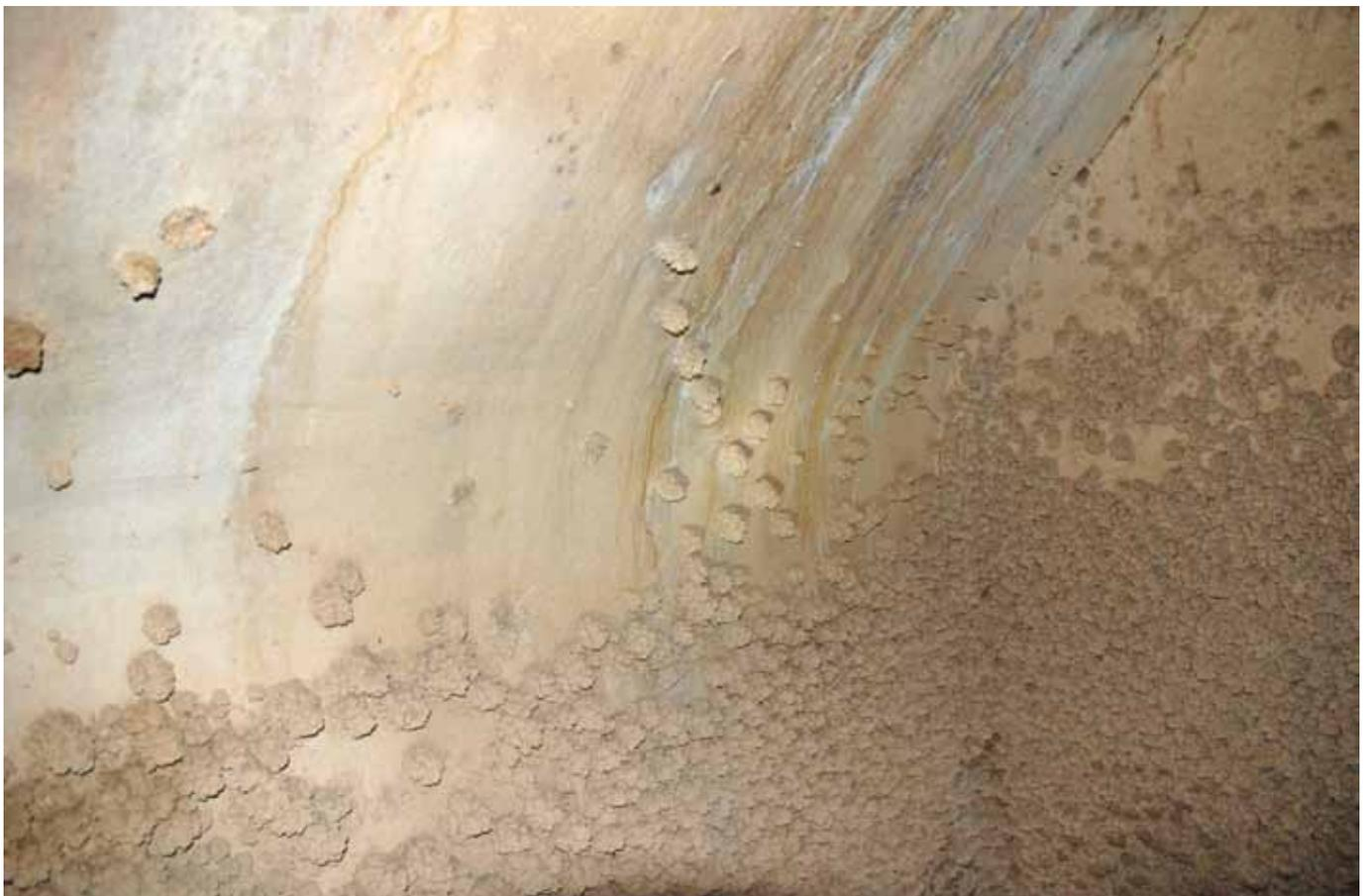
Fig. 9 – Cisterna C.3: concrezioni a cavolfiore (foto G. Ferrari).
