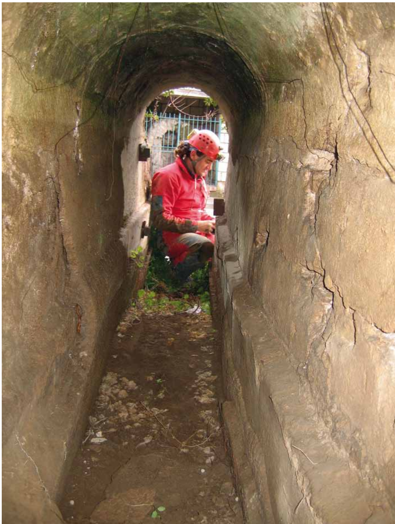
Fig. 4 – Pozzuoli, Via Olivetti: l'interno del condotto W con il deposito di concrezione ben al di sopra dell'intonaco idraulico (foto G. Ferrari).
