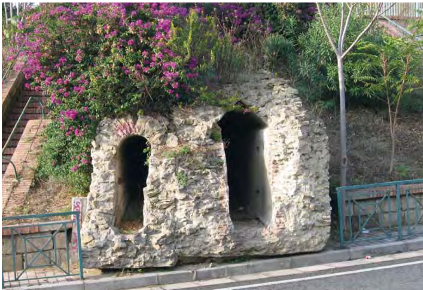
Fig. 2 – Pozzuoli, Via Olivetti: il doppio speco visto da sud. A sinistra (W) il condotto più antico (foto G. Ferrari).
