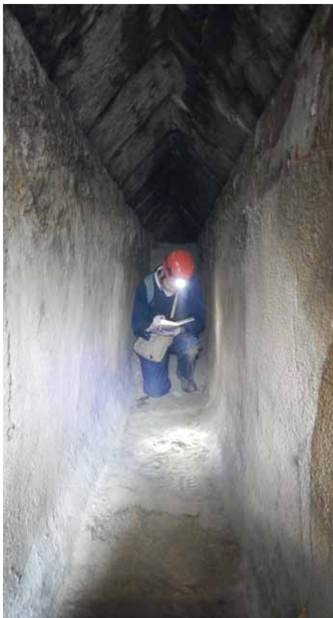
Fig. 5 – Pozzuoli, Via Olivetti: l'interno del condotto E (foto G. Ferrari).
