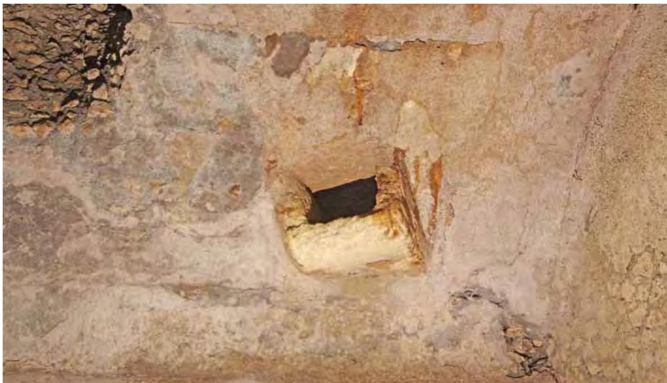
Fig. 3 – Particolare di una delle due bocche in travertino, di forma rettangolare, che si impostano nella cisterna del giardino vescovile all'altezza della volta (foto C. Germani).
