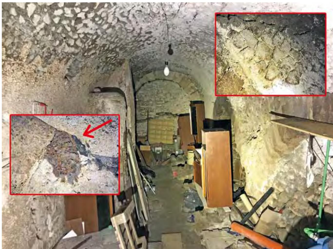
Fig. 9 – La cisterna di Palazzo Trajetto, oggi defunzionalizzata, con evidenziate le residuali tracce dell'*opus incertum* (in alto a dx) e della impermeabilizzazione (in basso a sx) (foto A. Schatzmann, elaborazione M. Abbate & C. Germani).
