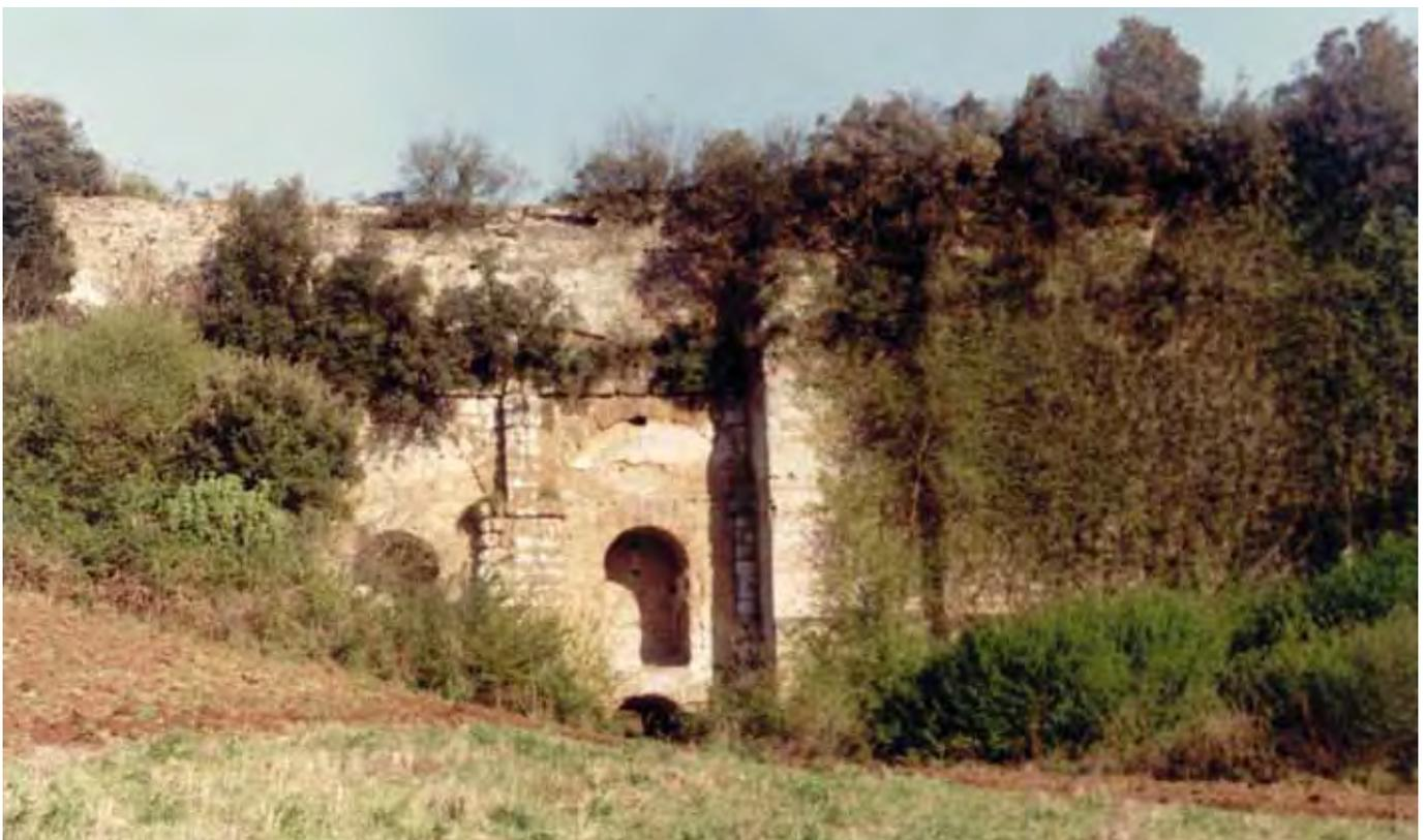
Fig. 7 – Vista di Ponte Lupo dell'acquedotto dell'*Aqua Marcia*, con le arcate originali in opera quadrata di tufo, rifasciate e rinforzate in opera laterizia di età imperiale. Edificato per oltrepassare la Valle dei Morti, San Vittorino di Roma (foto L. Casciotti).
