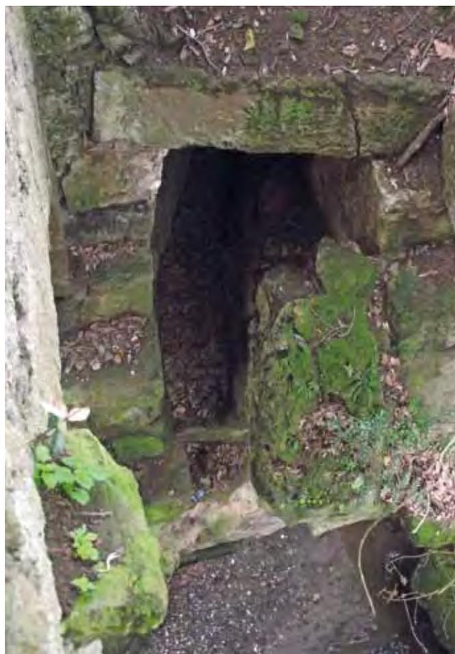
Fig. 5 – Particolare dello speco di ponte Pischero dell'acquedotto dell'Anio Vetus, crollato all'interno del Fosso di Caipoli, Gallicano nel Lazio - Roma (foto L. Casciotti).
