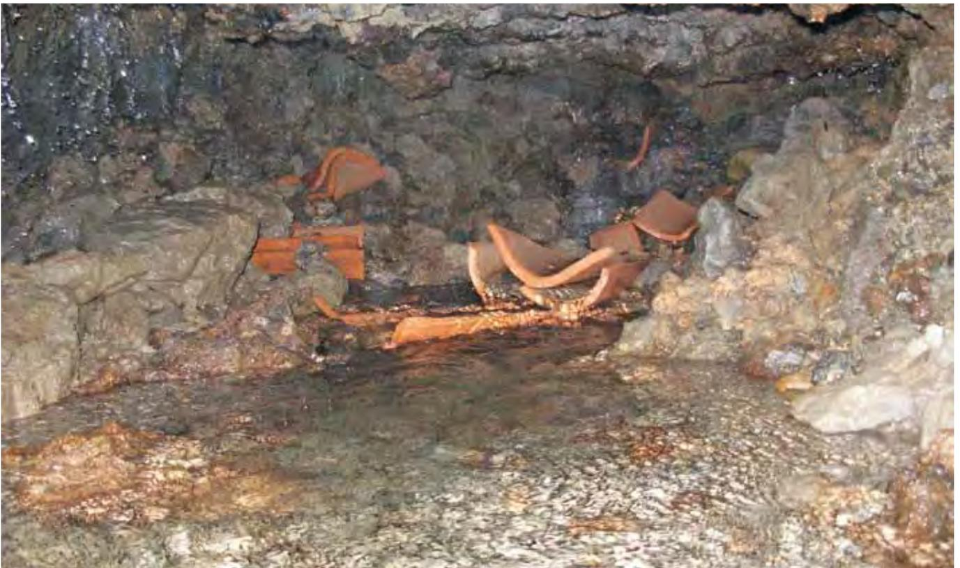
Fig. 9 – Qanat di Cifali: camera di drenaggio (foto A. Cariola).
