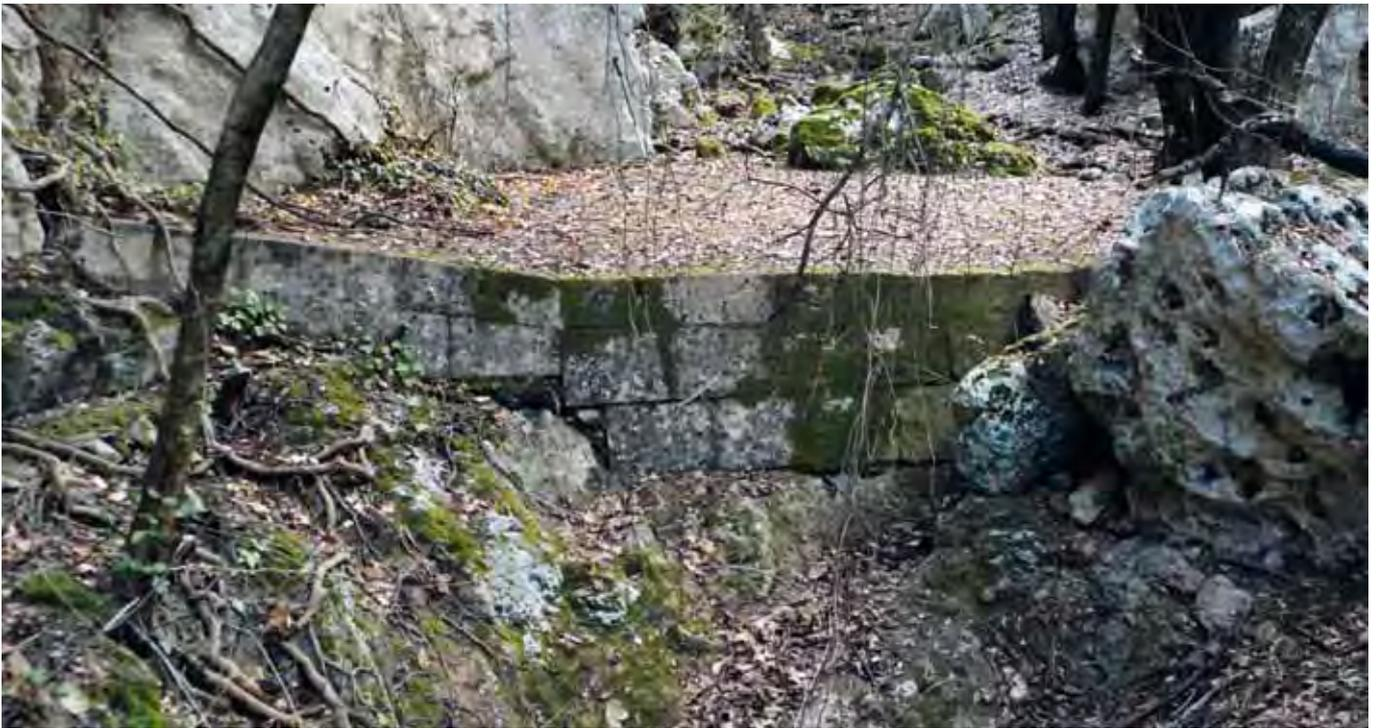
Fig. 7 – Pavimentazione di protezione realizzata con blocchi di calcare (foto P. Cultrera).
