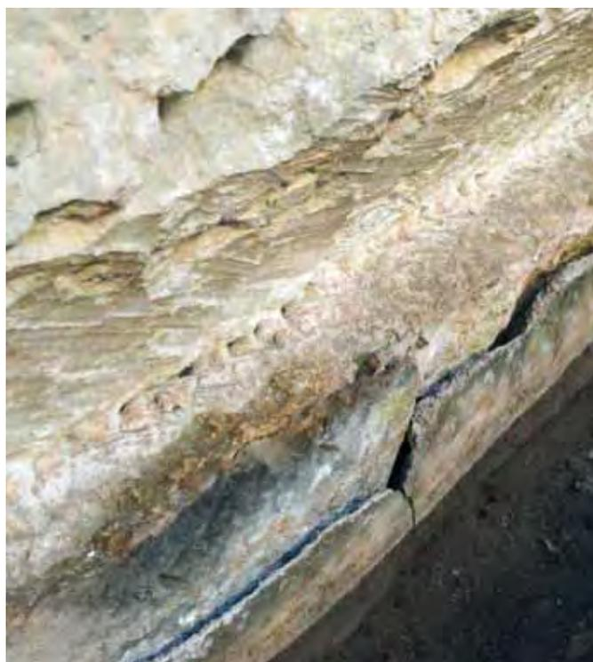
Fig. 6 – Dettaglio dell'intonaco a base cementizia (foto P. Cultrera).
