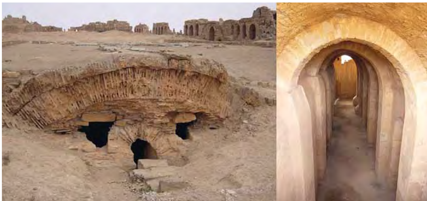
Fig. 2 – Imbocco (a sinistra) ed interno (a destra) di un sistema di raccolta del deflusso superficiale nell'antica città Siriana di Sergiopolis (Al Rasafa in arabo), costruita con blocchi di rocce gessose (foto di P. Madonia).
