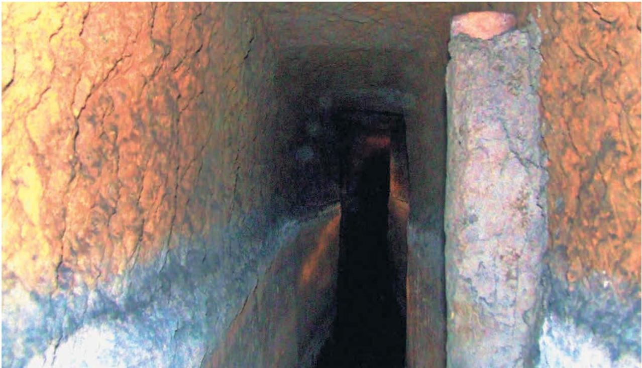
Fig. 15 – Dettaglio del tubo di terracotta addossato alla parete del cunicolo a 10,2 m di distanza dal P3 (foto R. Varriale).
