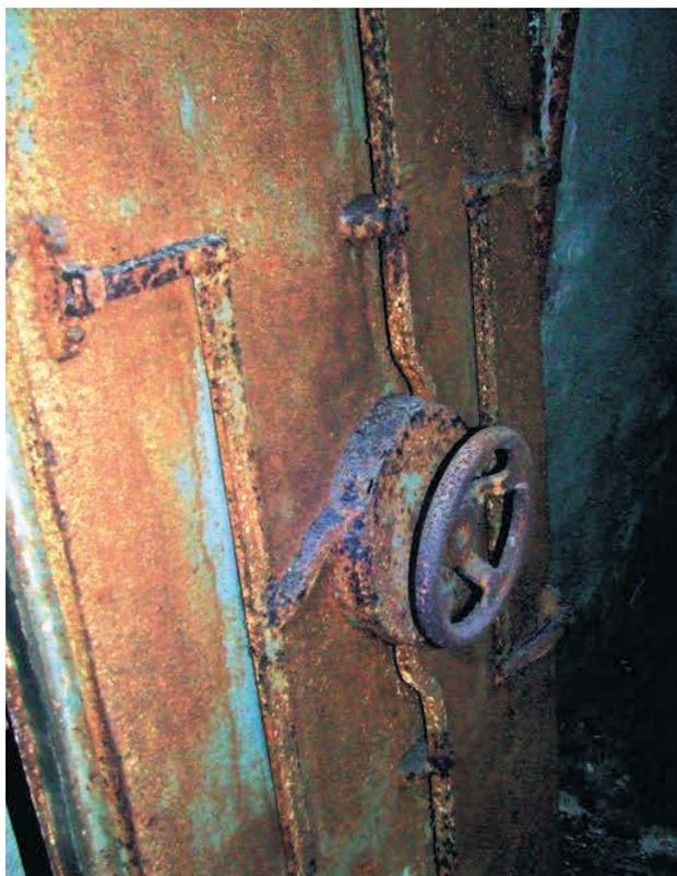
Fig.6 – Dettaglio della serratura installata sulla porta di sicurezza (foto R. Varriale).
