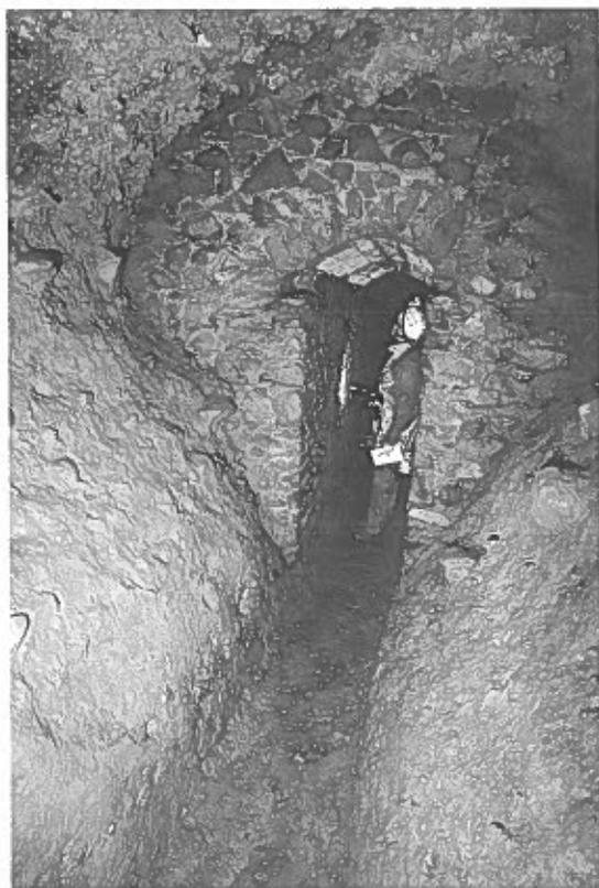
Foto 2.28: uno dei cunicoli di captazione dell'acquedotto di F. Tempesta CA184LaRM. Si notino le evidenti opere di ristrutturazione e consolidamento di epoca relativamente recente (foto C. Germani).
