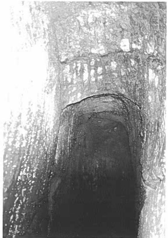
Foto 4.25: resti del fronte di scavo su un gradino della volta Foto V. Castellani).
