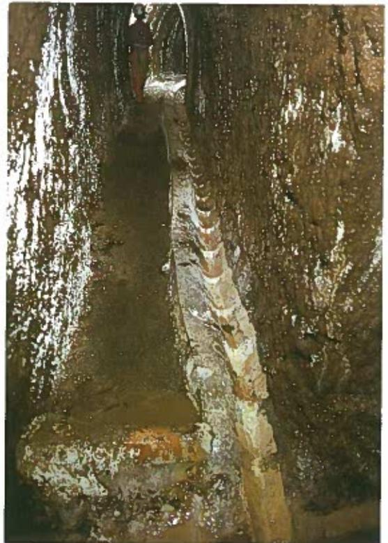
Foto 2.7: CA239LaRM - una diramazione del condotto principale, verso una falda laterale (foto C. Germani).
