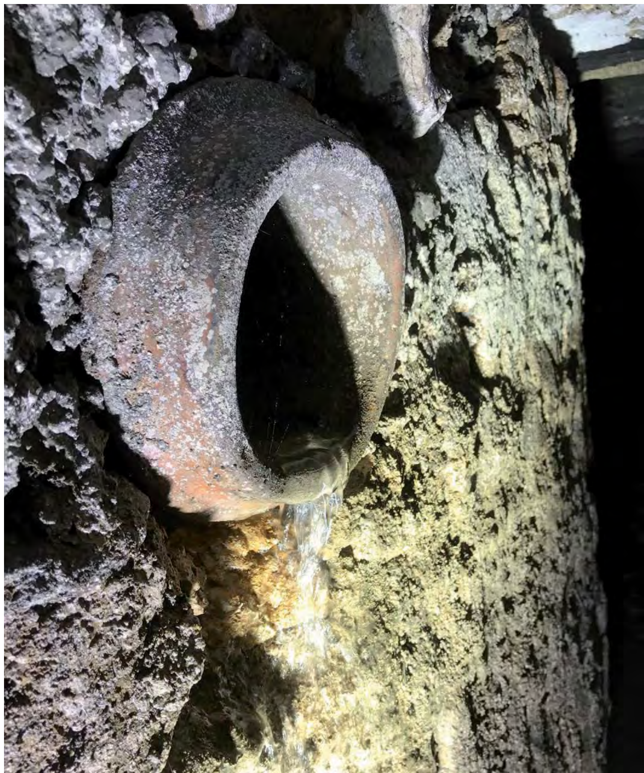
Fig. 15 – Particolare della condotta in laterizio (foto A. Schatzmann).
