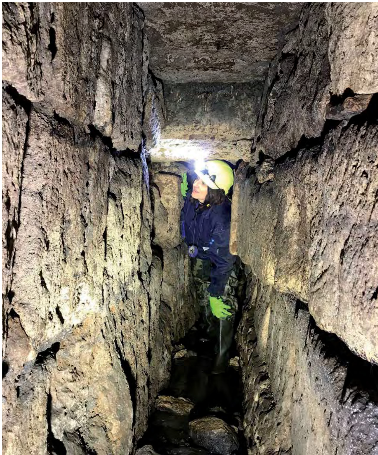
Fig. 13 – Cunicolo sotto il convento di Santa Chiara: tratti con copertura a lastroni (foto A. Schatzmann).
