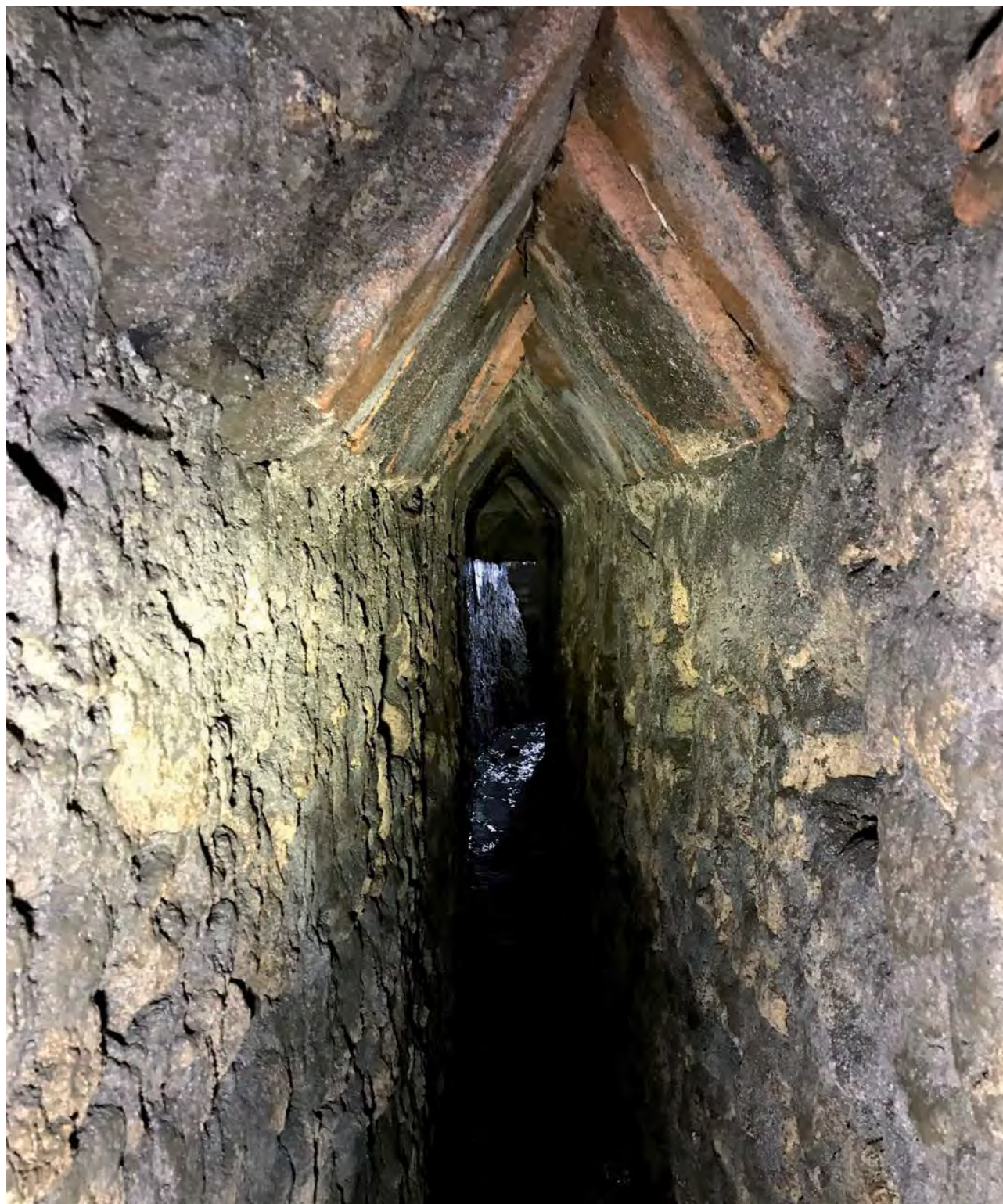
Fig. 14 – Cunicolo sotto il convento di Santa Chiara: tratti con copertura a cappuccina in laterizi rettangolari (foto A. Schatzmann). Fig. 14 – Conduct under S. Chiara Monastery: section with cappuccina covering with rectangular tiles (photo A. Schatzmann).
