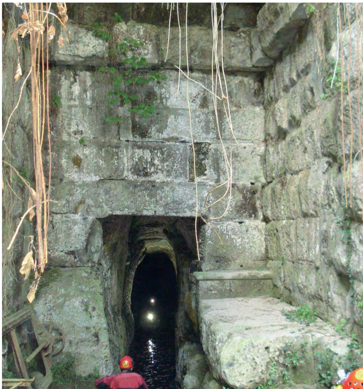
Fig. 8 – Inizio dell'esplorazione dell'emissario Albano. Il tunnel scavato nel peperino s'inoltra rettilineo all'interno della collina (foto C. Germani).
