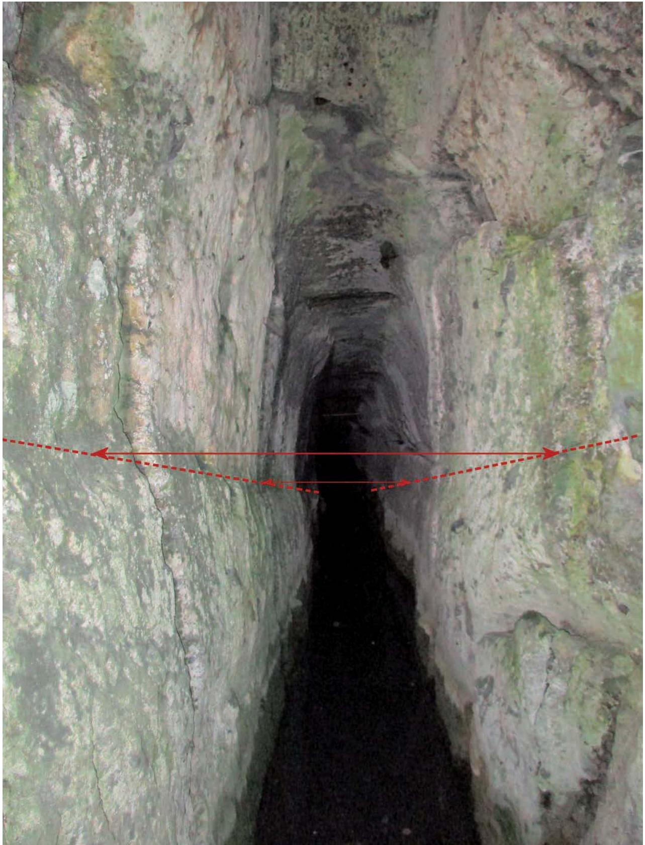
Fig. 12 – Resti del margine del primo pavimento del cunicolo inclinato (discenderia), evidenziato dalle linee rosse. In una fase successiva il pavimento è stato scavato e ribassato sino al livello dell'attuale canale (foto L. Casciotti).
