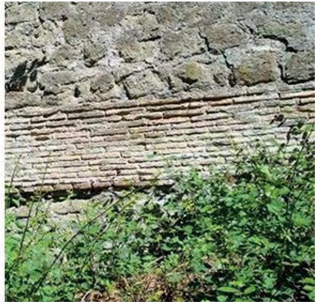
Fig. 31 – Vista della cortina muraria del canale idrico, in località “Le Mole”, al servizio del primo mulino di Albano Laziale. Particolare del più basso canale idrico in opera laterizia, con modulo di età romana (foto L. Casciotti).
