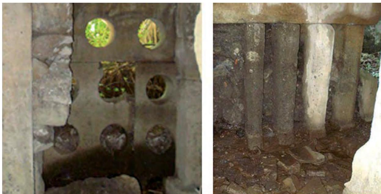
Fig. 26 – Particolare della prima parete forata filtrante e della seconda parete filtrante a setti verticali con lo spazio tra le partizioni ostruito (foto L. Casciotti).
