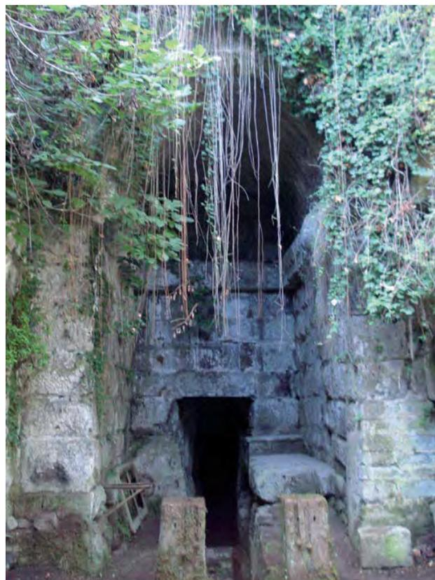
Fig. 6 – Grande fornice monumentale, in evidente abbandono, eretto a “protezione” dell’ingresso sotterraneo dell’emissario Albano. Il tunnel è scavato all’interno della collina sulla quale sorge l’abitato di Castel Gandolfo (Roma) affacciato sulla costa occidentale del lago omonimo (foto L. Casciotti).
