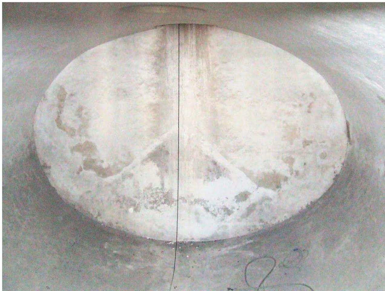
Fig. 4 – Napoli, Certosa di S. Martino. Cisterna pluviale di forma ovoidale (foto R. Varriale).
