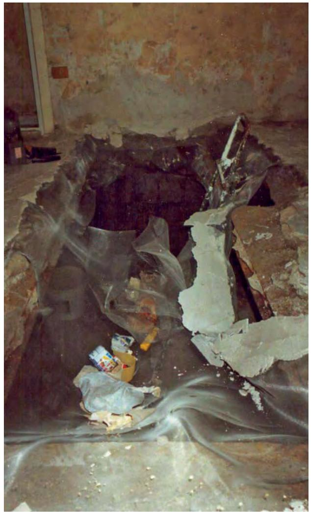
Fig. 12 – Napoli, cavità artificiale a vico Cimitile 16. Area dello sprofondamento avvenuto all'interno dell'abitazione (foto R. Varriale).
