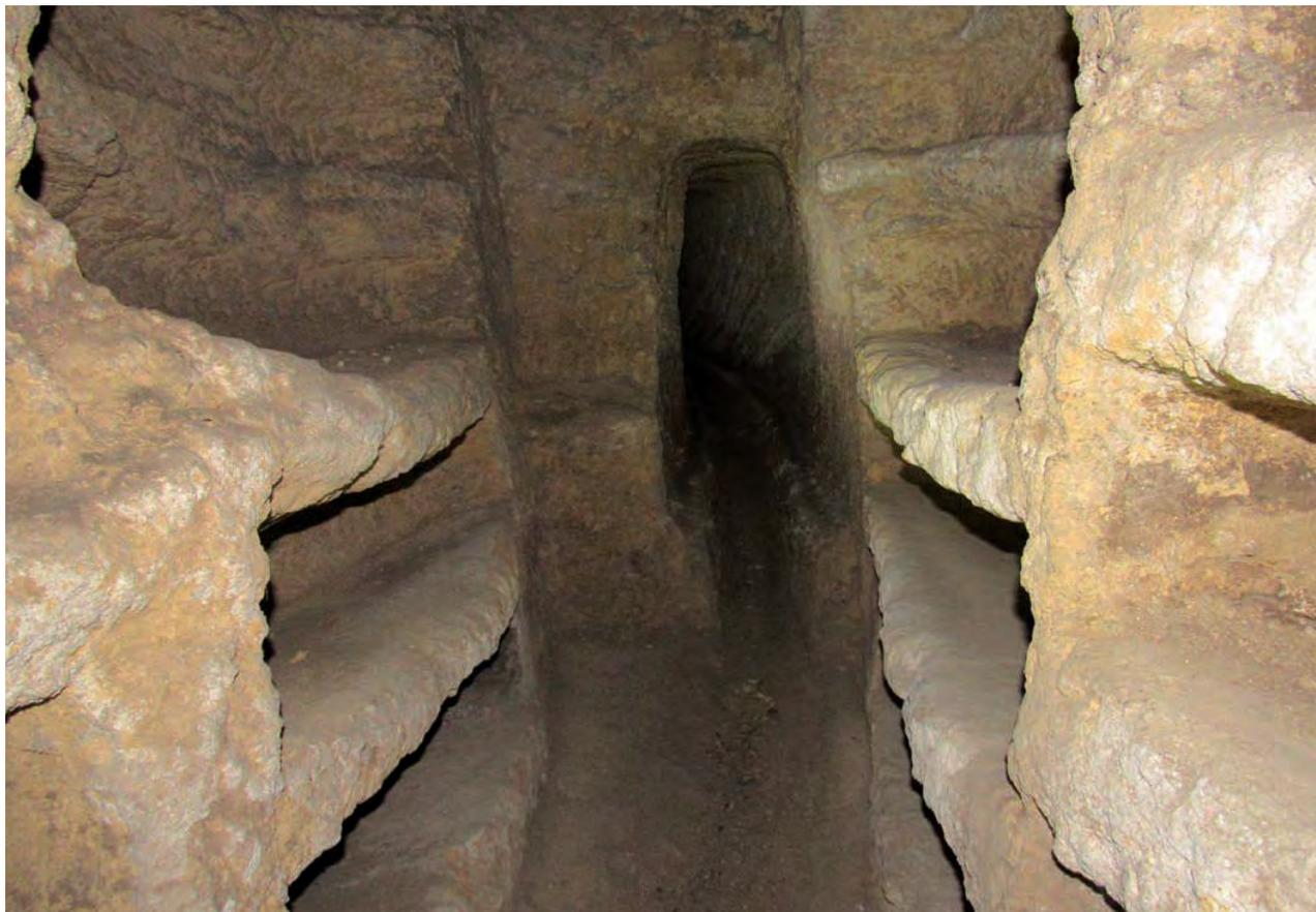
Fig. 13 – La galleria dell’acquedotto ancora integra all’interno della catacomba S. M. Di Gesù (foto L. Arena).
