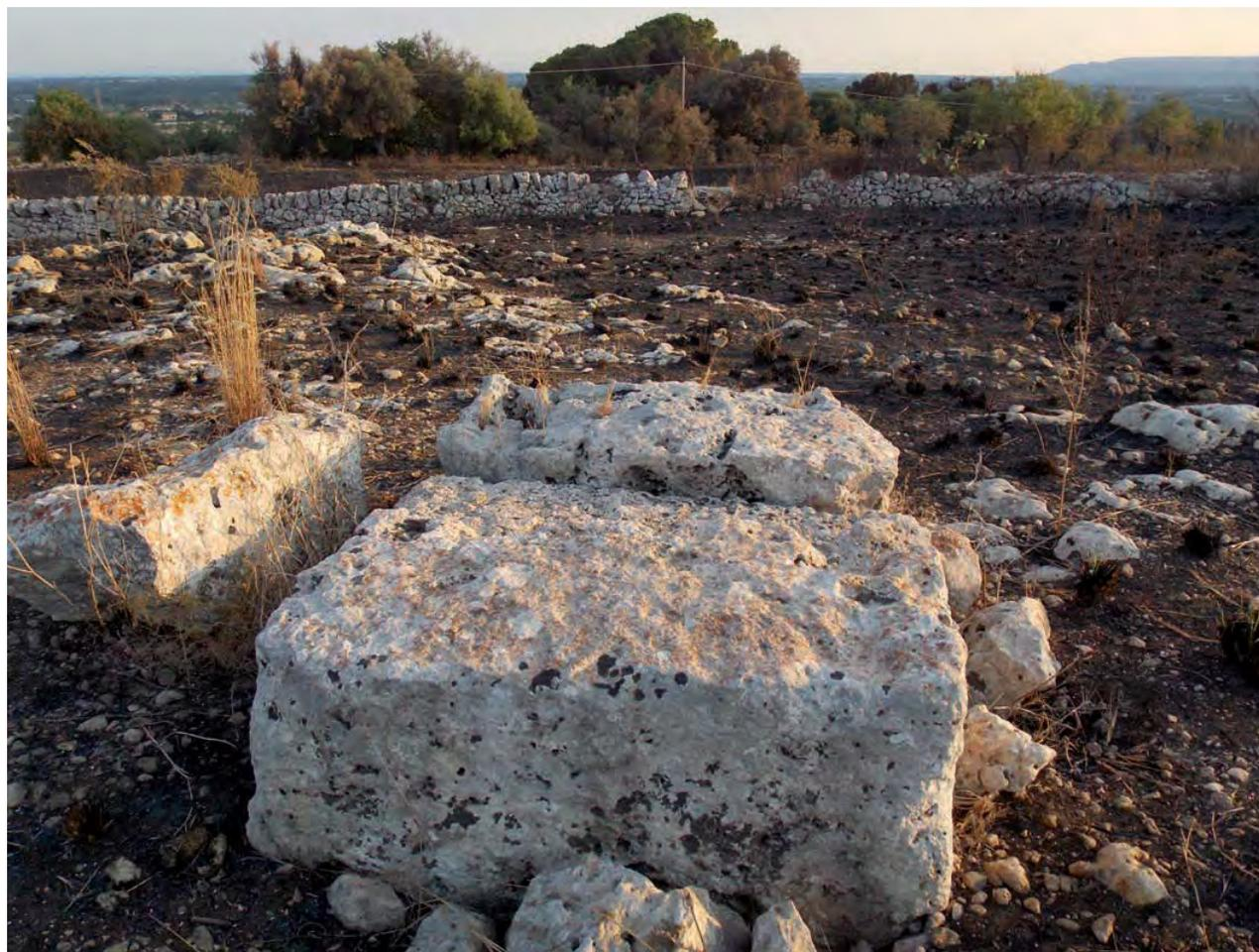
Fig. 5 – Lastroni di copertura dei pozzi di accesso acquedotto Tremilia (foto L. Arena).
