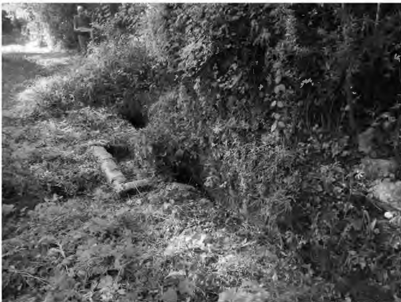
Fig. 9 – Canale a cielo aperto con vasca in pietra tra la Fontana di Giove e il traforo di Giove (foto S. Del Prete®).
