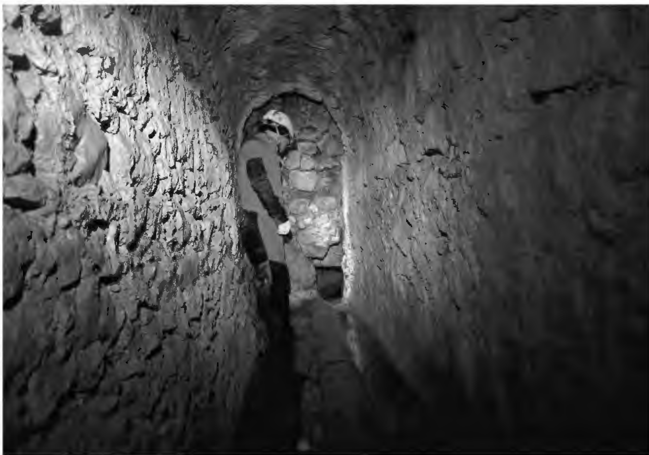
Fig. 12 – Parete in muratura di blocchi calcarei con canaletta di fondo proveniente dalla Fontana di Giove (foto S. Del Prete®).
