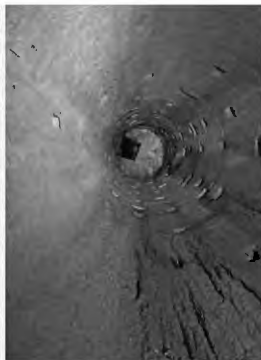
Fig. 3 – Fori di drenaggio lungo le pareti del traforo di Giove e lungo le pareti dei pozzi (foto S. Del Prete®).
