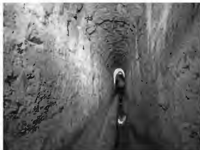
Fig. 24 – Ramo secondario di Pozzovetere. Ingresso e tunnel con la canaletta laterale (foto S. Del Prete®).
