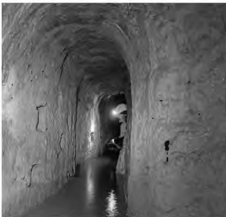
Fig. 3 – Fori di drenaggio lungo le pareti del traforo di Giove e lungo le pareti dei pozzi (foto S. Del Prete®).
