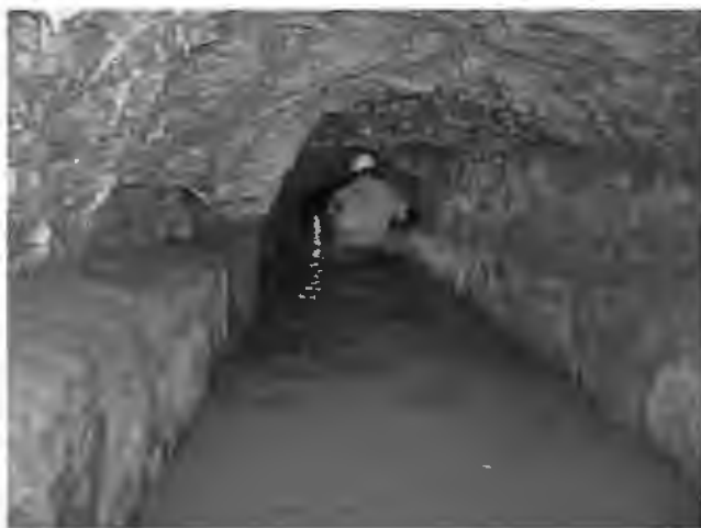
Fig. 19 – Il secondo tratto del tunnel di Forano quasi completamente allagato e il cedimento della parete laterale che ostruisce parzialmente la galleria (foto G. Minieri®).
