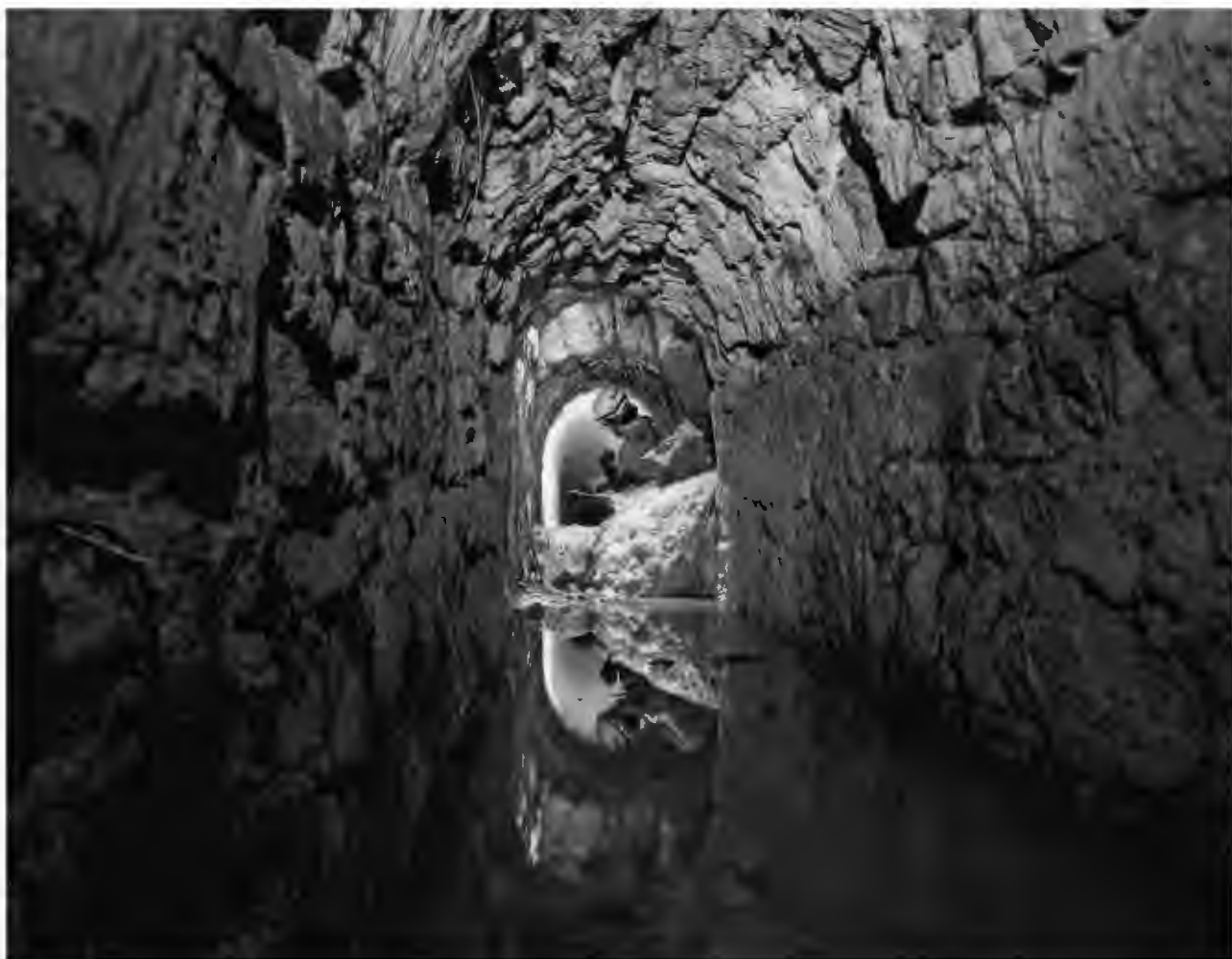
Fig. 18 – Traforo di Forano. All'imbocco della discenderia si nota la colata di calcite formata dall'acqua del ramo proveniente da Fontanelle (foto S. Del Prete®).
