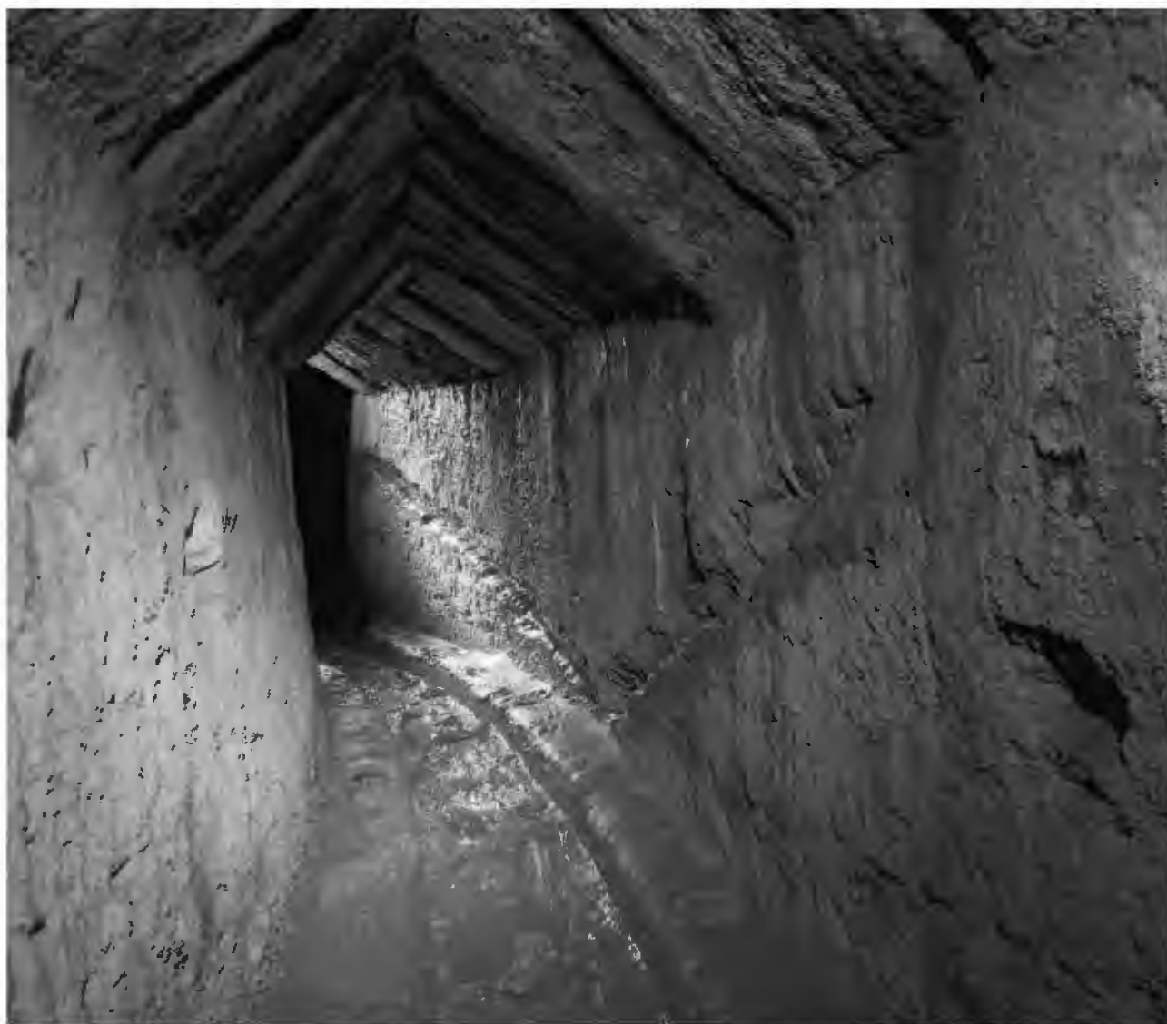
Fig. 22 – Una delle profonde incisioni a "V" presenti lungo le pareti del traforo di Piscignano (foto S. Del Prete®). Fig. 22 – One of the deep "V" incisions along the walls of the Piscignano tunnel (photo S. Del Prete®).
