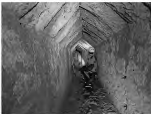
Fig. 21 – Traforo di Piscignano. Settore in roccia tufacea e settore con pareti foderate e soffitto a doppia falda (foto S. Del Prete®). Fig. 21 – Piscignano tunnel. Sector in tuff rock and cladded sector with gabled roof (photos S. Del Prete®).
