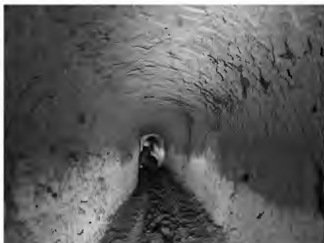
Fig. 21 – Traforo di Piscignano. Settore in roccia tufacea e settore con pareti foderate e soffitto a doppia falda (foto S. Del Prete®). Fig. 21 – Piscignano tunnel. Sector in tuff rock and cladded sector with gabled roof (photos S. Del Prete®).
