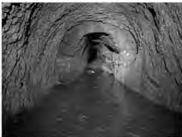
Fig. 19 – Il secondo tratto del tunnel di Forano quasi completamente allagato e il cedimento della parete laterale che ostruisce parzialmente la galleria (foto G. Minieri®).
