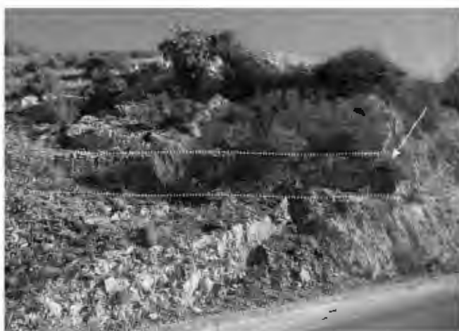
Fig. 28 – Parte del secondo tratto dell'acquedotto Giove Fontanelle, tagliato durante l'allargamento della carreggiata della strada provinciale per Casertavecchia; nella foto a destra un tratto del condotto come si presenta al suo interno (foto S. Del Prete®).
