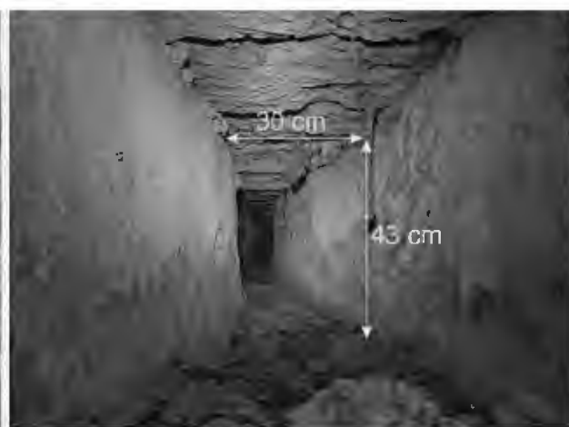
Fig. 28 – Parte del secondo tratto dell'acquedotto Giove Fontanelle, tagliato durante l'allargamento della carreggiata della strada provinciale per Casertavecchia; nella foto a destra un tratto del condotto come si presenta al suo interno (foto S. Del Prete®).
