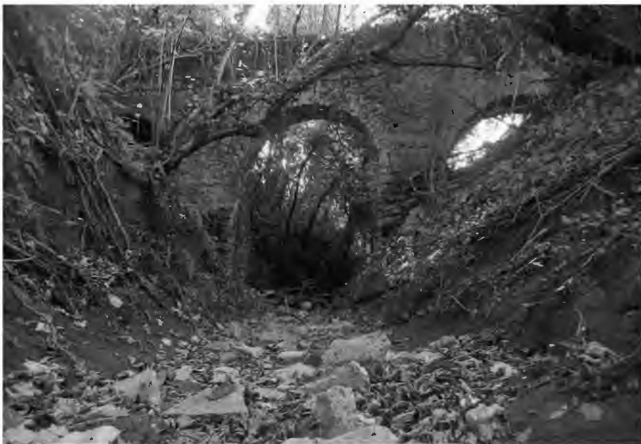
Fig. 23 – Ponte-canale ad archi in muratura attraverso il Vallone del Campo (foto S. Del Prete®).
