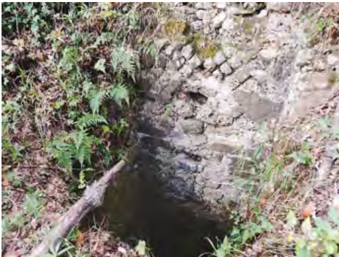
Fig. 7 - Uno dei 25 pozzi rilevati (foto V. Colombo).
