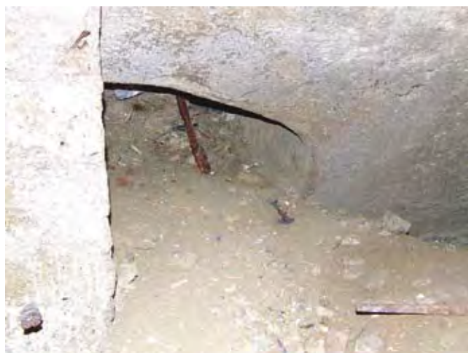
Fig. 13 - Dettaglio del pozzo indicato nel rilievo topografico della camera principale con il n. 3 (foto R. Varriale).
