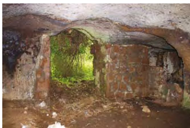
Fig. 5 - Ingresso visto dall'interno, con dettaglio del rinforzo in blocchetti. A destra si nota il muro più basso che delimita l'ambiente abitativo del pastore. In alto sulla volta, si vede il punto d'origine della primitiva escavazione, forse un corridoio di accesso (foto archivio Bottacchiari).
