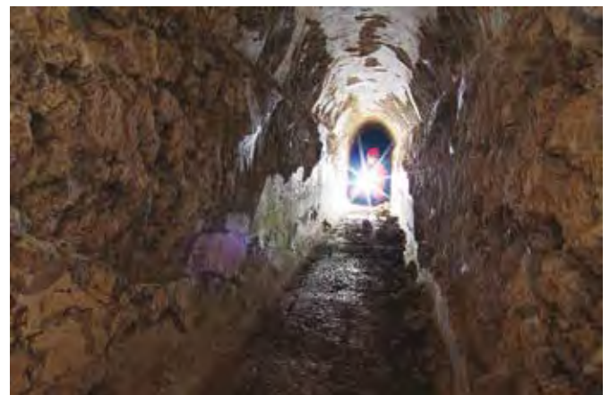
Fig. 9 - Il tratto di condotto inclinato di 18° (foto C. Germani).
