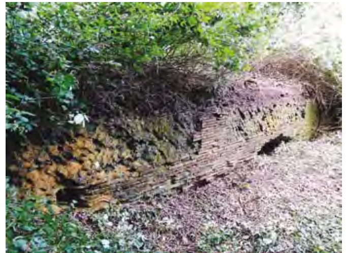
Fig. 8 - Attraversamento del primo torrente (foto V. Colombo).
