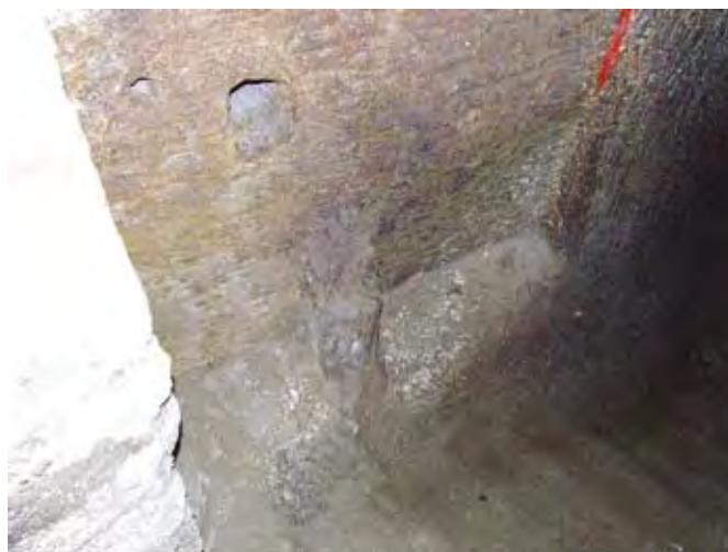
Fig. 15 - Resti delle strutture di un probabile sistema di sarcofagi all'interno dell'ipogeo e indicati nel rilievo topografico con il n. 4 (foto R. Varriale).
