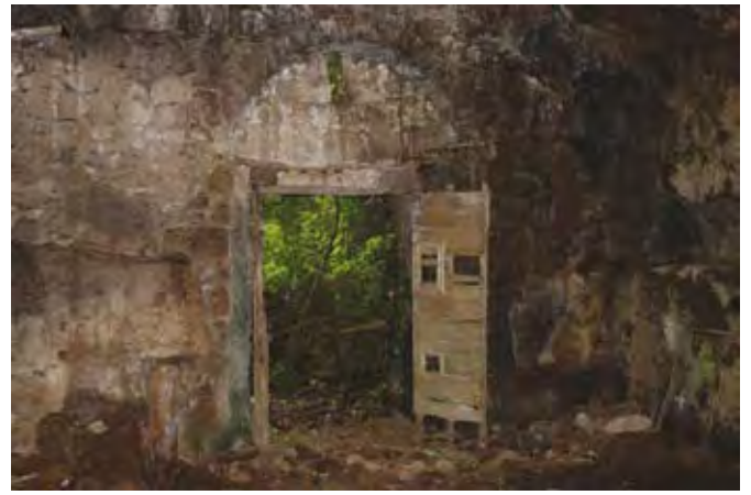
Fig. 15 - Dettaglio della porta d'ingresso e dell'arco di rinforzo (foto archivio Bottacchiari).
