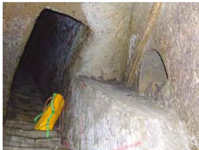
Fig. 10 - Dettaglio del collegamento della scala di accesso nel soffitto dell'ipogeo a 14,60 m di profondità (foto R. Varriale).
