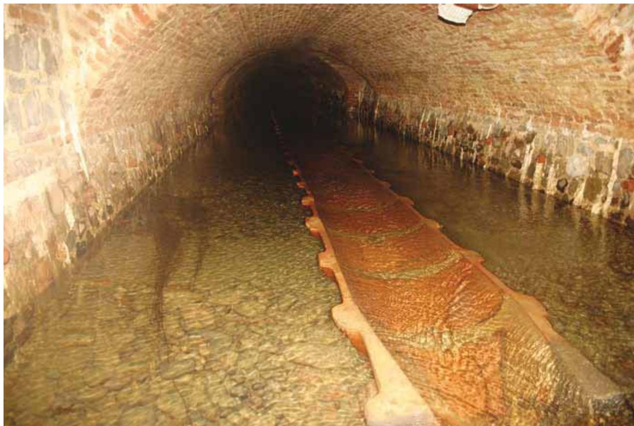
Fig. 2 - La Galleria Longitudinale Corsi (1882), lunga 148 m, drena le acque dalle ghiaie del terrazzo alluvionale in destra Setta (foto D. Demaria).
