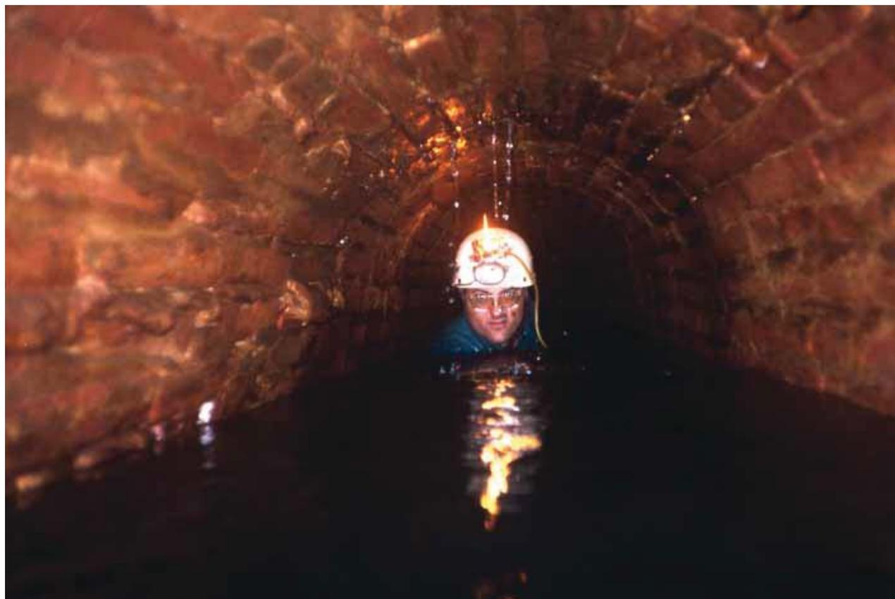
Fig. 5 - La Galleria Trasversale (1887), lunga 139 m, drena le acque di sottocorrente del Setta (foto D. Demaria).
