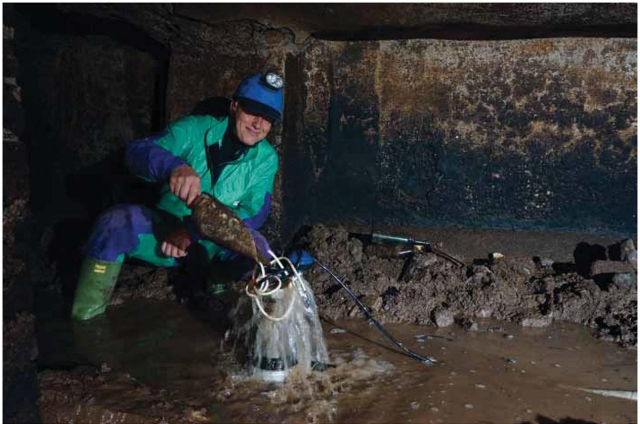
Fig. 6 - La cisterna mediana della Villa dei Quintili a Roma: dopo la rimozione di acqua e fango, si raffredda manualmente la pompa ormai emersa (foto S. Barbaresi).
