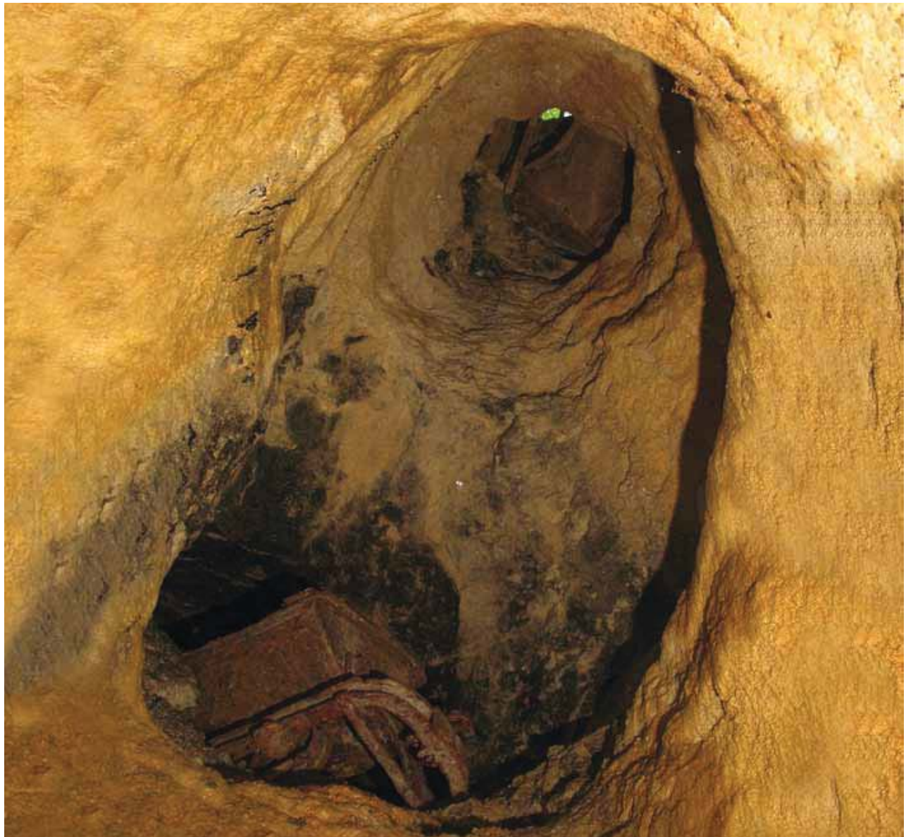
Fig. 5 - Il pozzo. È possibile notare il carrello pericolosamente incastrato all'imbocco (foto E. Orsini).
