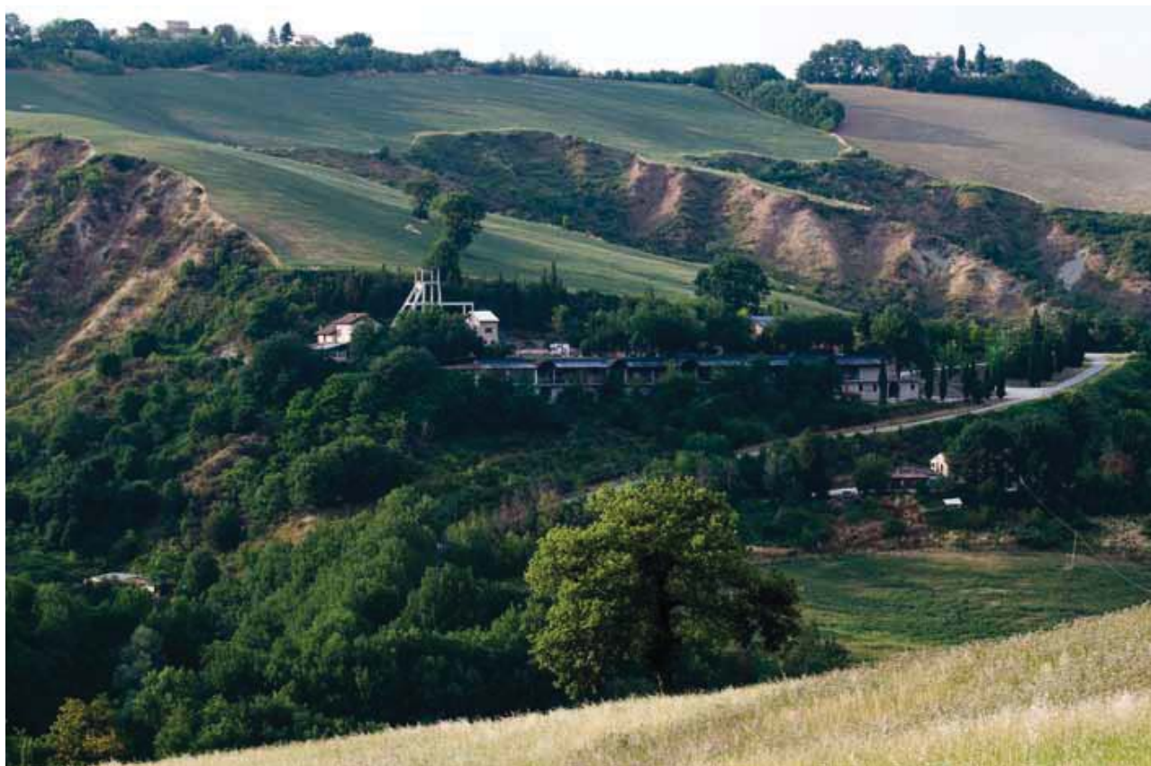
Fig. 15 - Panoramica del cantiere di Pozzo Donegani, ora agriturismo "La Corte della Miniera" (foto E. Diakatos A.).
