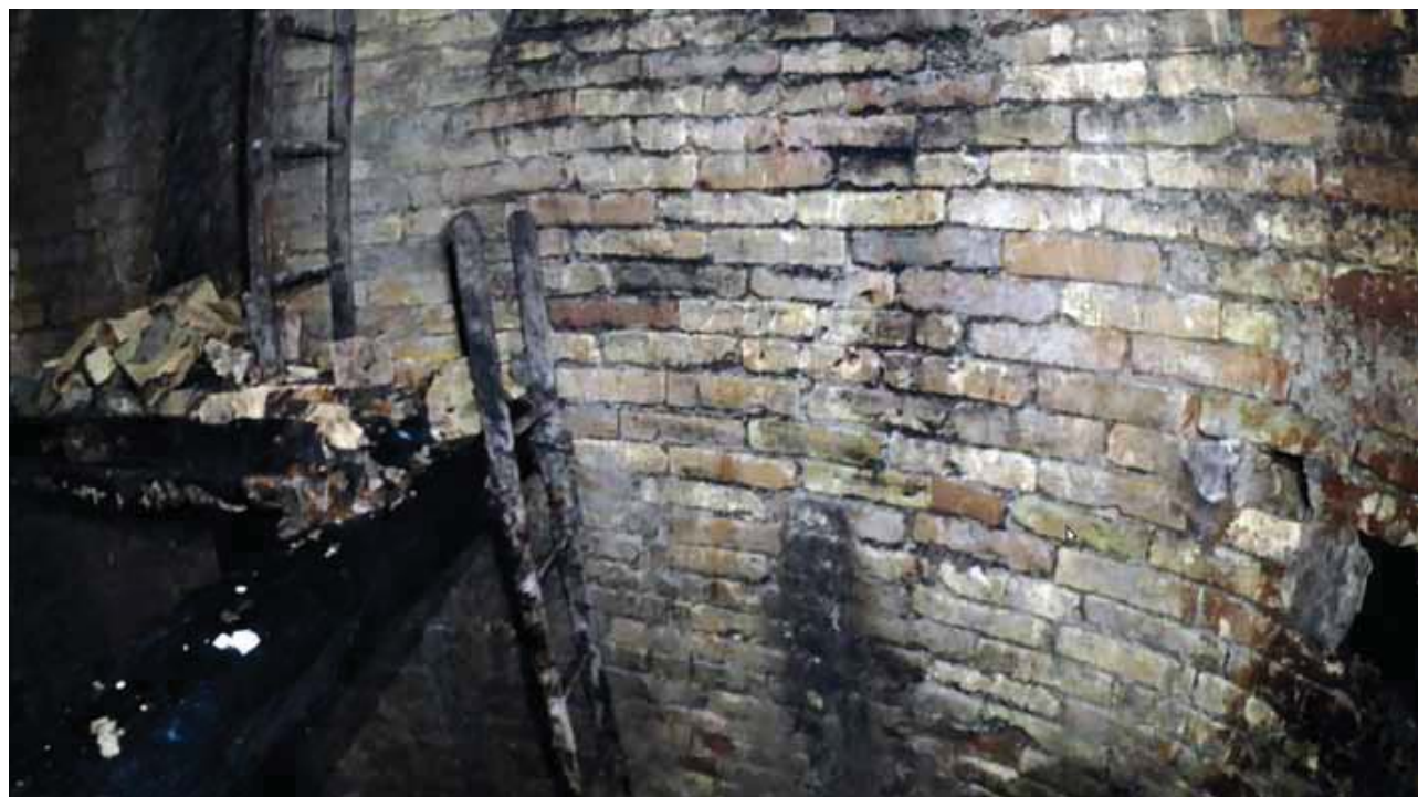
Fig. 14 - Scala di servizio a pozzo Donegani (fotogramma video M. L. Garberi).
