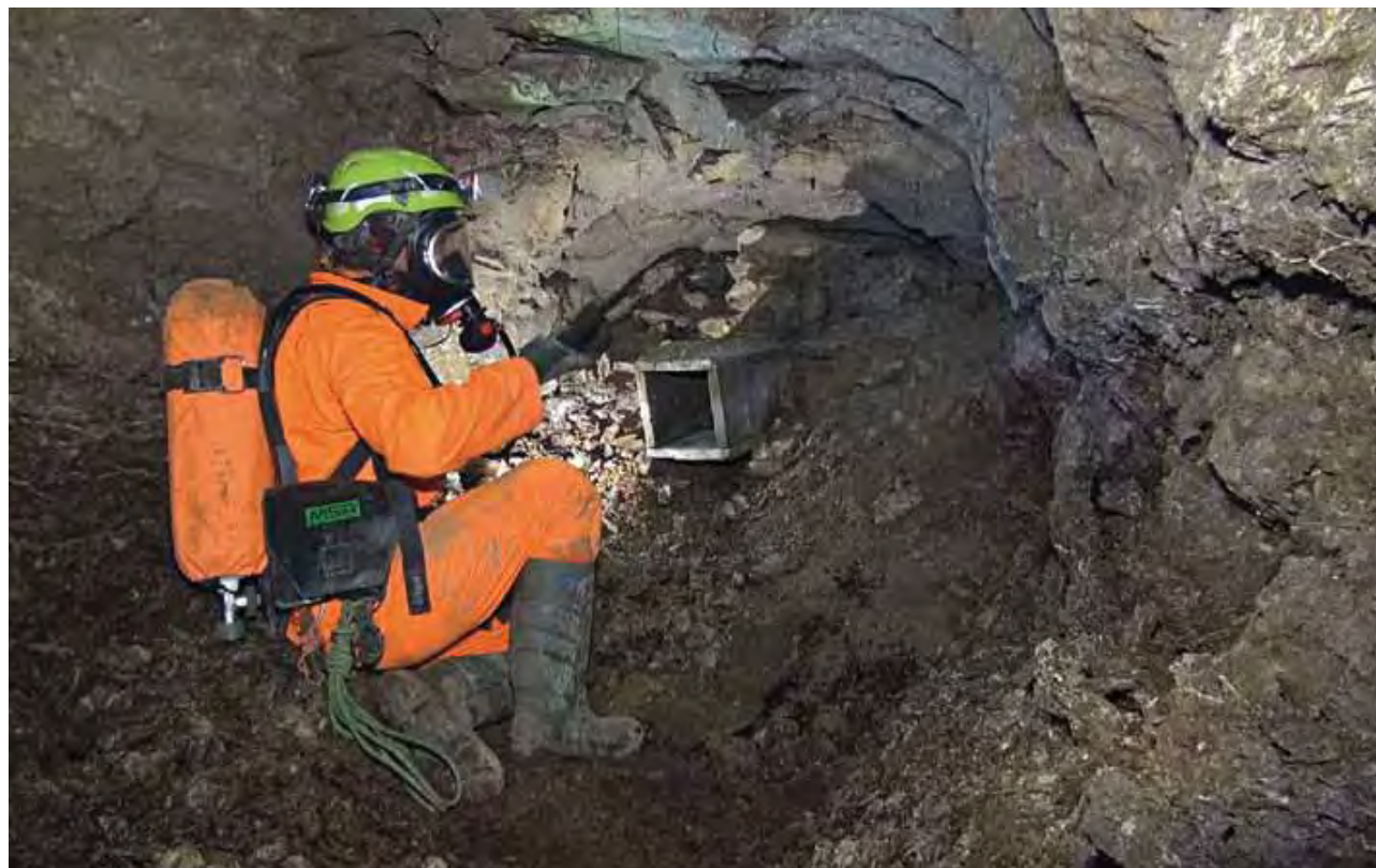
Fig. 15 - Sbarramento artificiale, attraversato da un probabile condotto di areazione (fotogramma video M. L. Garberi).
