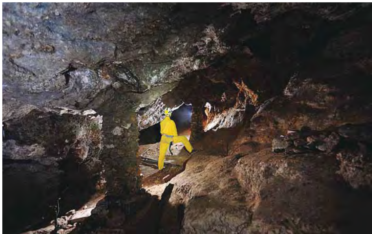
Fig. 32 - Consolidamenti all'interno della Solfatara di Predappio Alta (foto G. Belvederi). Fig. 32 - Reinforcement in the Solfatara of Predappio Alta (photo G. Belvederi).
