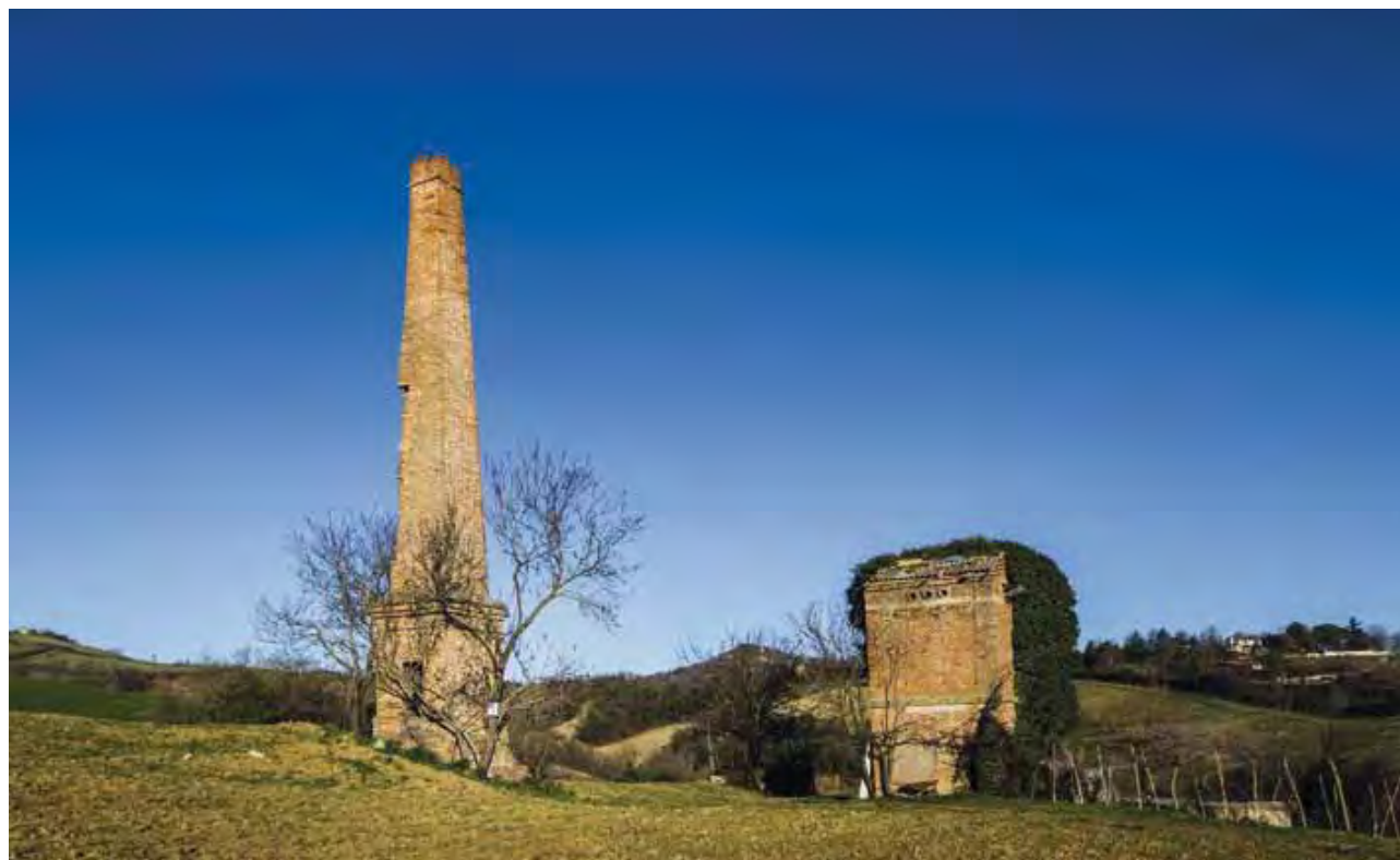
Fig. 25 - Cabina elettrica e camino della macchina a vapore per l'argano a Luzzena (foto P. Lucci).
