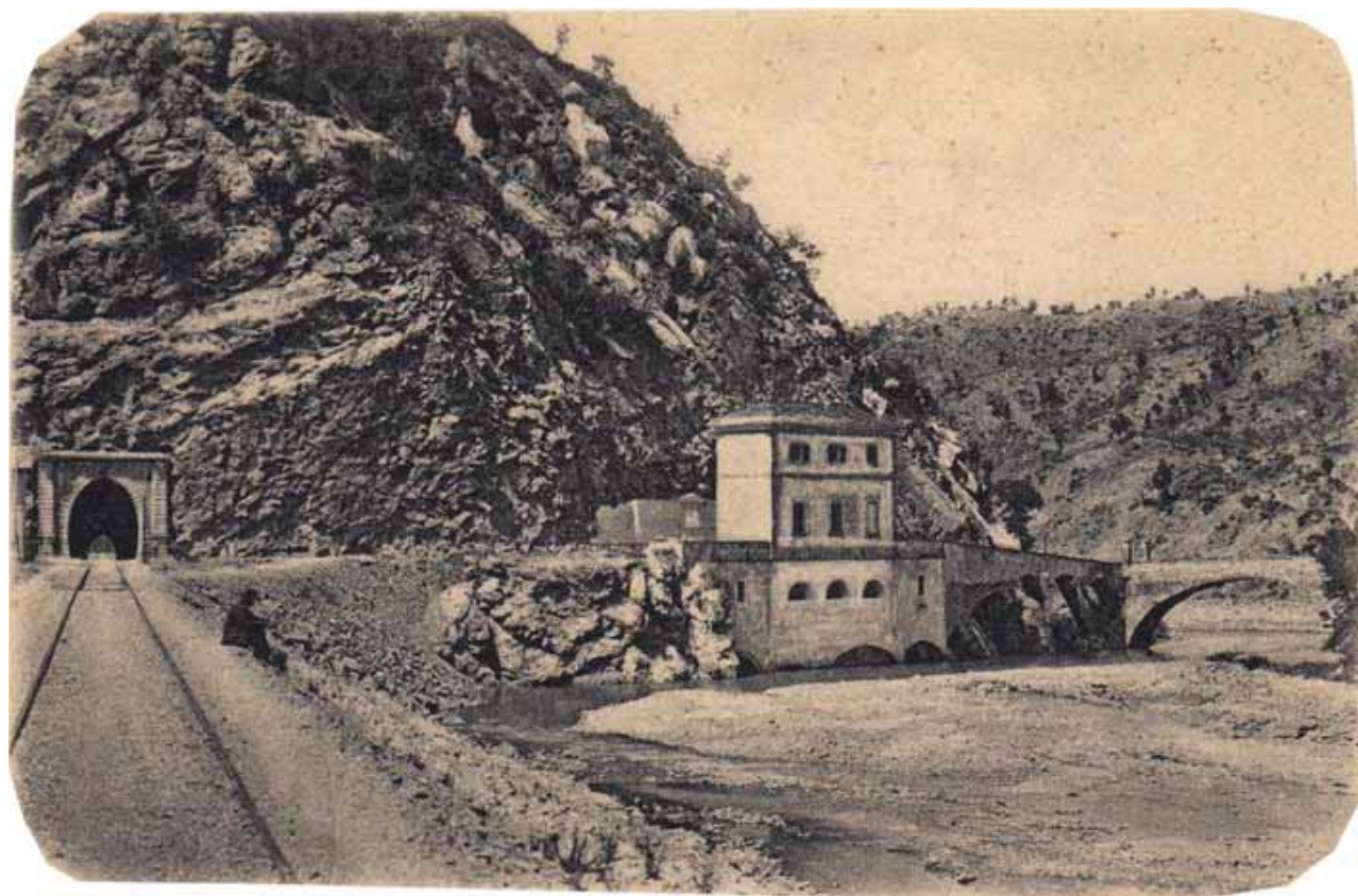
Fig. 3 - Vecchia foto (ante 1895). Sulla sinistra compare la galleria ferroviaria al cui interno sgorga la sorgente della Madonna; al centro l'edificio della Porretta Vecchia, prima degli ultimi interventi realizzati in quell'anno; la sorgente è all'interno dello stabile, pochi decimetri sopra il livello del fiume.
