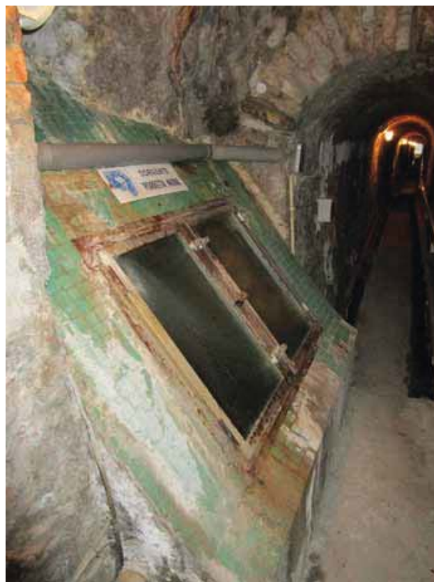
Fig. 5 - La sorgente Porretta Nuova, scoperta il 20 aprile 1887 all'interno della galleria, alla progressiva 65 m (foto D. Demaria). Fig. 5 - The Porretta New Spring, discovered the 20 th April, 1887, inside the tunnel, at a distance of 65 m from the entry (photo D. Demaria).
