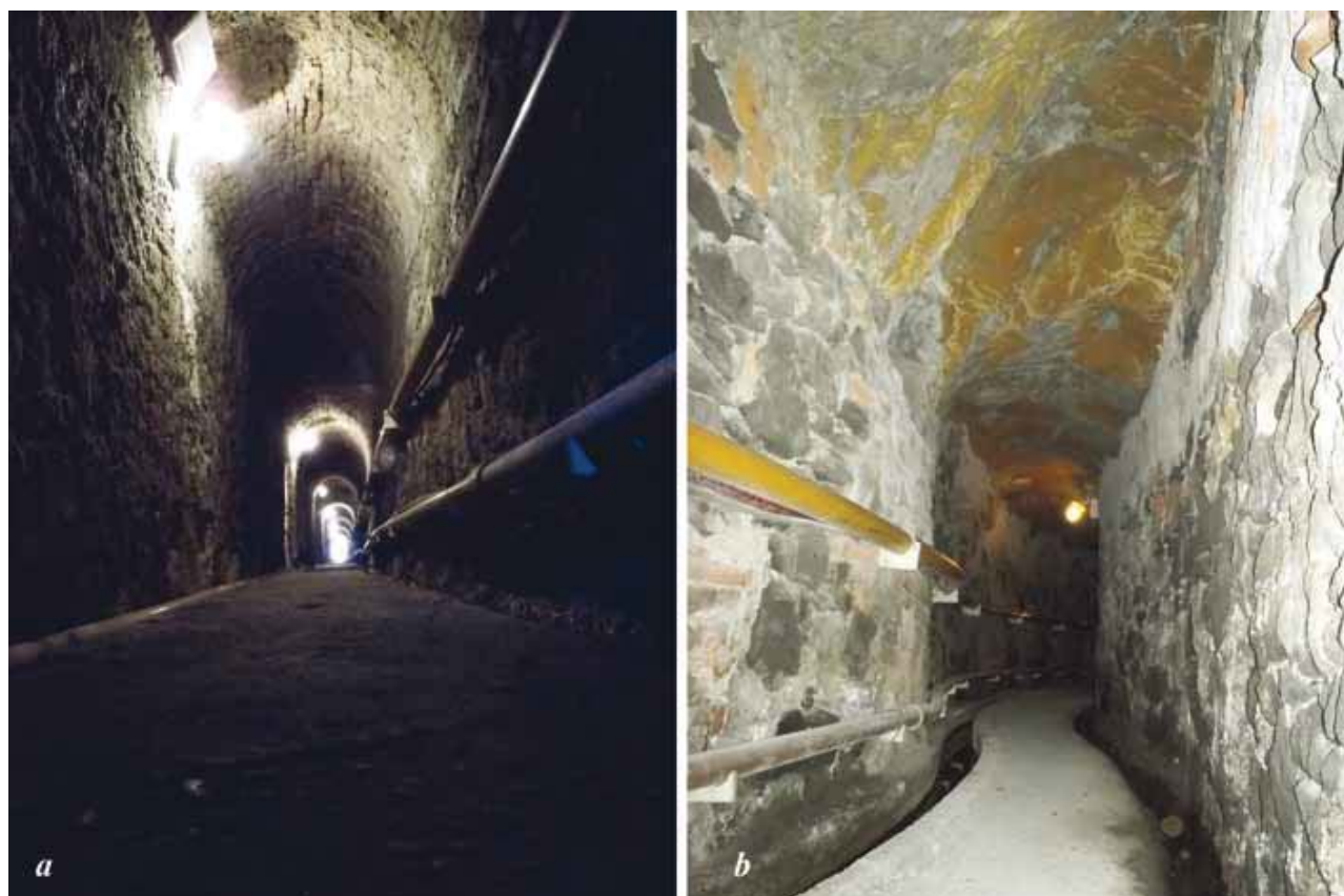
Fig. 6 - Due aspetti della galleria fra Puzzola e Porretta Vecchia: a) con rivestimento in paramento murario in blocchi di pietra (piedritti) e mattoni (volta); b) con la volta in roccia e piedritti in blocchi di pietra, nel punto di incontro fra squadre opposte di scavatori. I tubi convogliano le acque termali allo stabilimento della Puzzola (foto D. Demaria).
