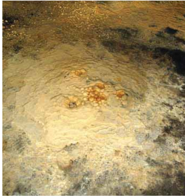
Fig. 13 - Galleria S. Martino: le bellissime fioriture calcaree presenti nella galleria (foto H. De Santis).
