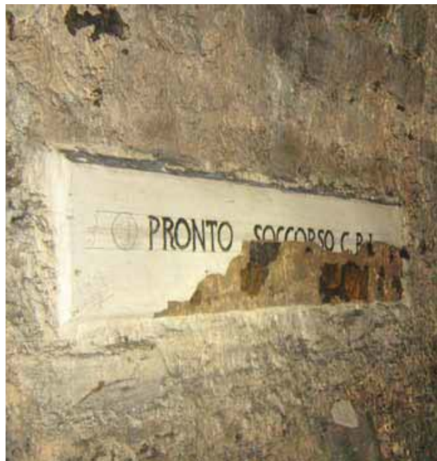
Fig. 11 - Galleria S. Martino: testimonianze del posto di pronto soccorso (foto H. De Santis).
