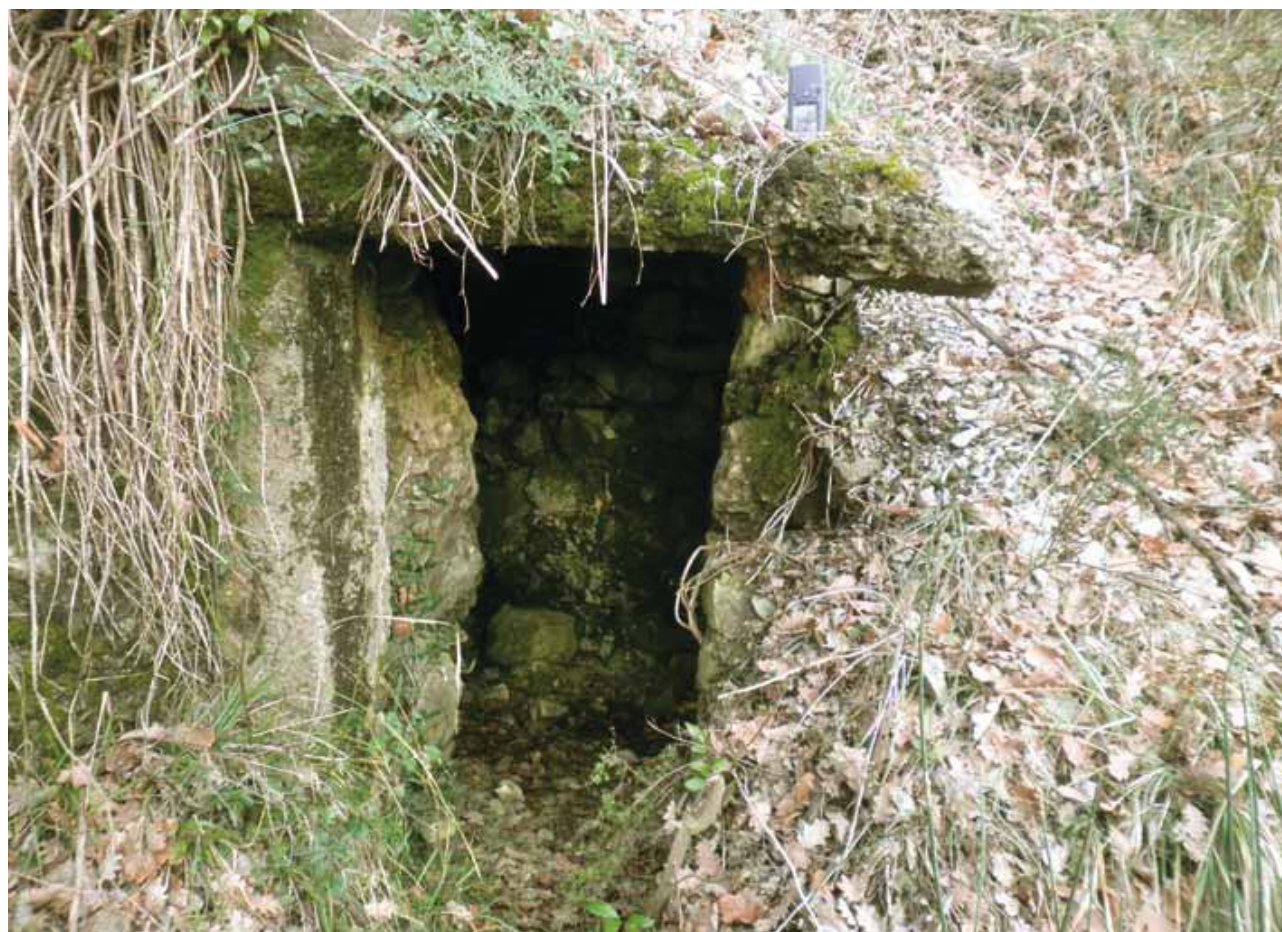
Fig. 16 - Rifugio di Molassana Alta: il primo ingresso della struttura (foto H. De Santis). Fig. 16 - Molassana Alta-shelter: the main entrance (photo H. De Santis).
