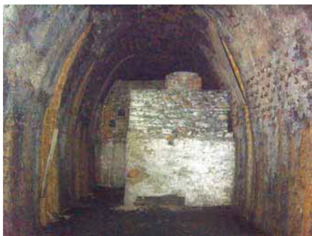
Fig. 9 - Galleria S.Martino: particolari dei muri antisoffio (foto H. De Santis).
