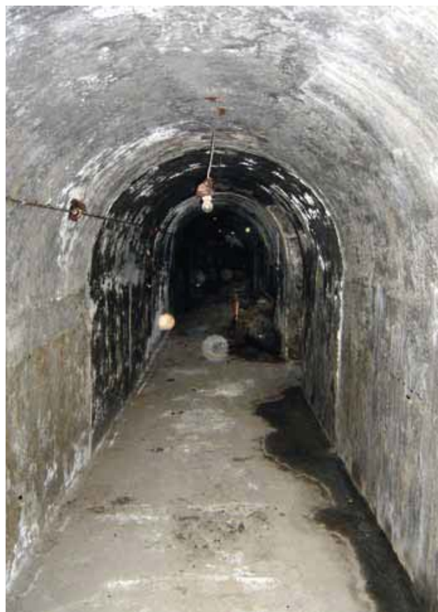
Fig. 5 - Rifugio delle "Officine del Gas": L'interno del lungo corridoio centrale (foto H. De Santis).
