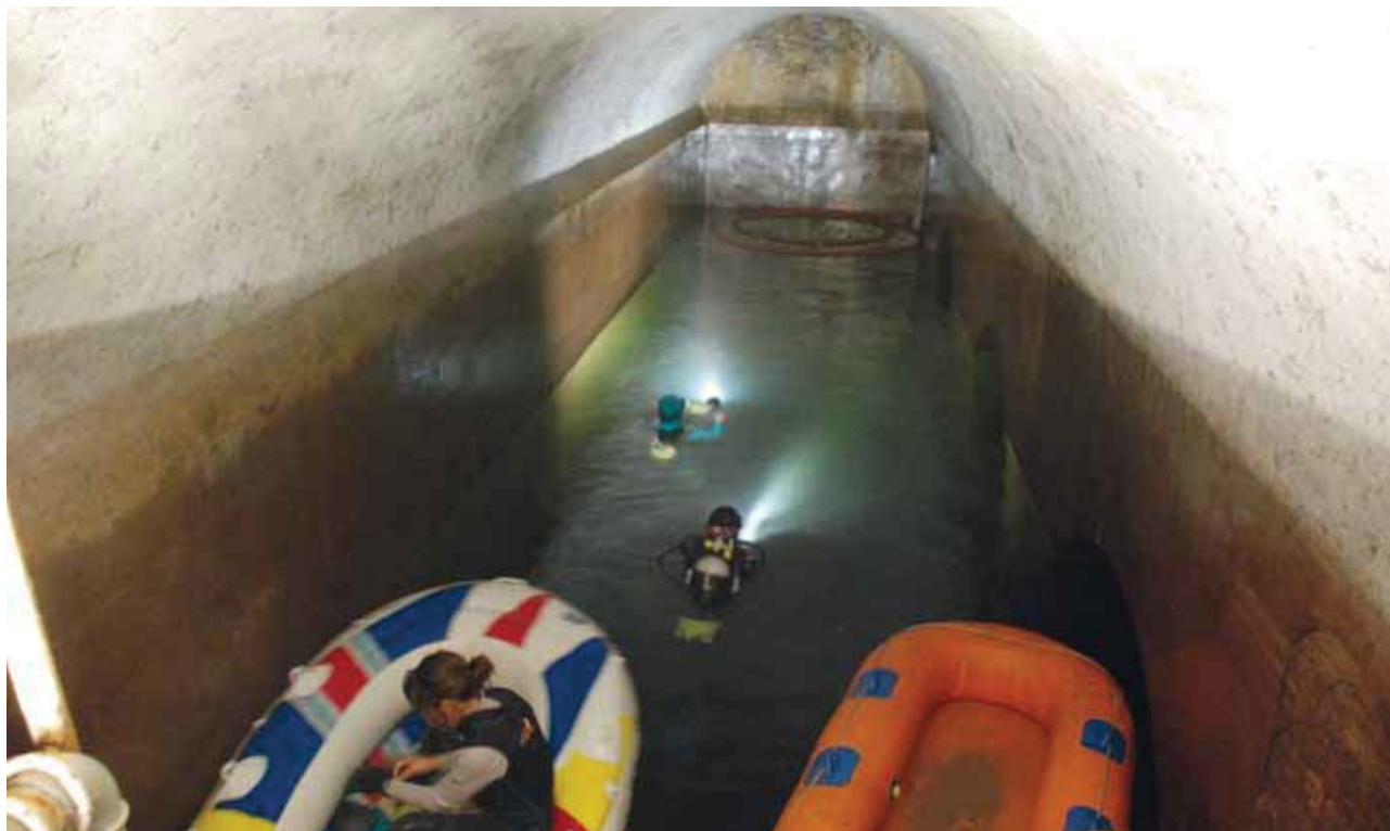
Fig. 10 - I subacquei in azione dopo l'abbassamento del livello dell'acqua che ha fatto emergere le tre arcate della parete meridionale (lato destro) del settore n. 1 della cisterna. Il medesimo ambiente, fotografato prima delle attività, è visibile nella figura 7 (foto N. Di Clemente).
