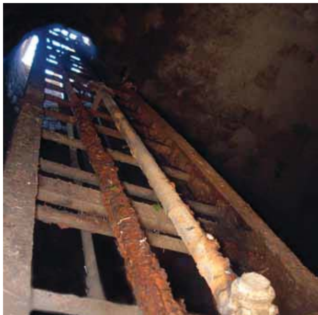
Fig. 11 - Scala metallica moderna (lavori degli anni '90) che dalla base della cisterna sale fino alla superficie attraverso la canna del pozzetto (foto Centro Paguro).
