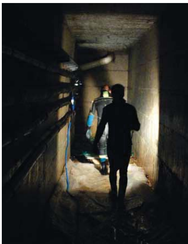
Fig. 6 - Il cunicolo tecnologico ipogeo che conduce ad uno degli accessi alla cisterna (foto Paguro) Fig. 6 - The technological hypogeal tunnel leading to one of the cistern entries (photo Centro Paguro).
