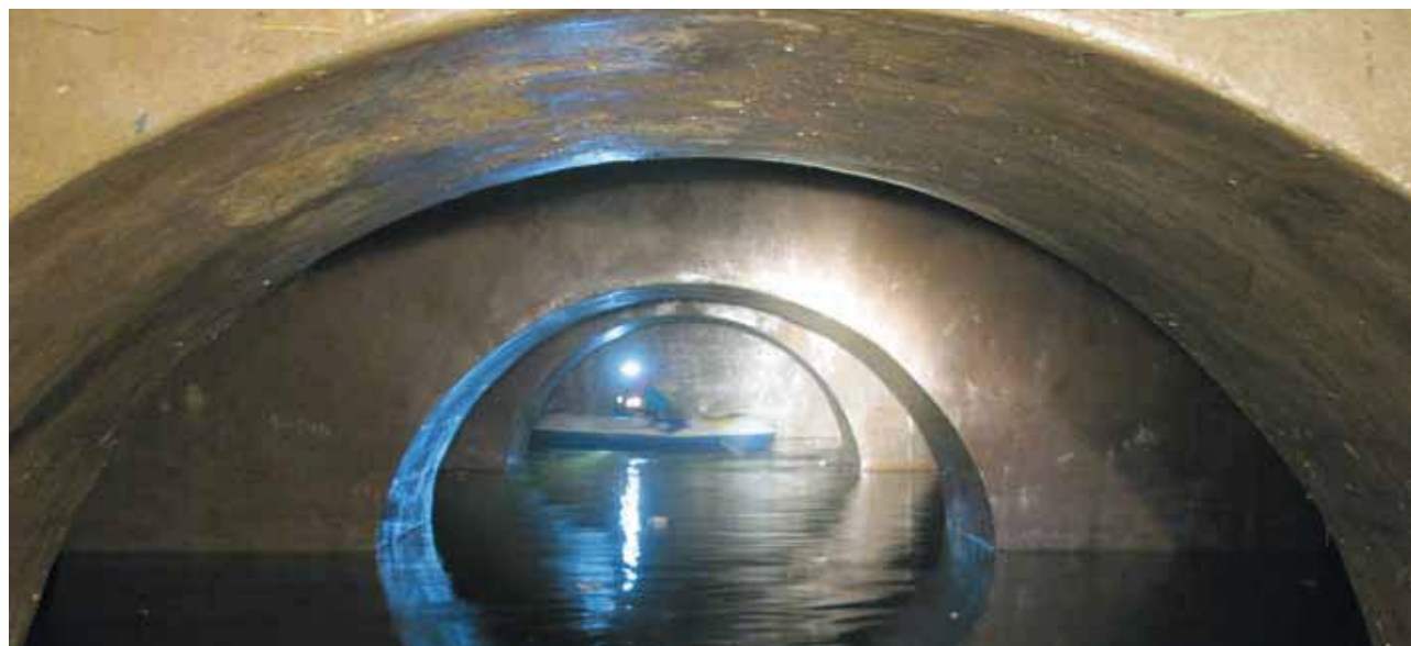
Fig. 13 - Le arcate di collegamento dei sei comparti voltati a botte di cui si compone la cisterna. Sullo sfondo uno dei canotti utilizzato per la "navigazione sotterranea" (foto M. Traverso). Fig. 13 - The connecting arches of the six barrel vault compartments of which the cistern is made. In the background the boat used for underground navigation (photo M. Traverso).
