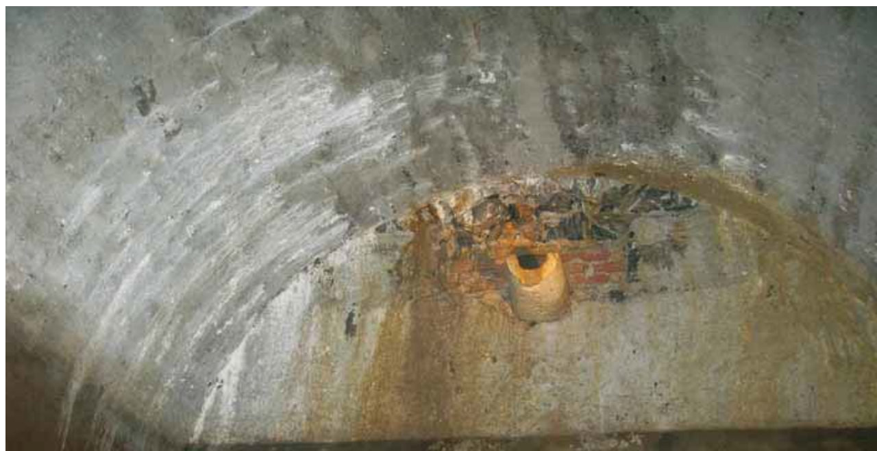
Fig. 20 – Il doccione, in marmo di Carrara, dal quale fuoriusciva l'acqua che si immetteva nella cisterna. Il doccione, e la porzione di lunetta soprastante, sembrano essere stato rimaneggiati in occasione dei moderni restauri del complesso fortificato (foto S. Saj). Fig. 20 – The gargoyle, made of Carrara marble, from which poured out the water entering the cistern. The gargoyle, and the overhead part of the lunette, seem to be rehased during the modern restorations of the fortified complex (photo S. Saj).
