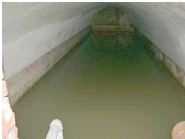
Fig. 8 - Ecco come appariva lo spazio della cisterna affacciandosi dalla finestrella presente al termine del cunicolo tecnologico sotterraneo (foto S. Saj).
