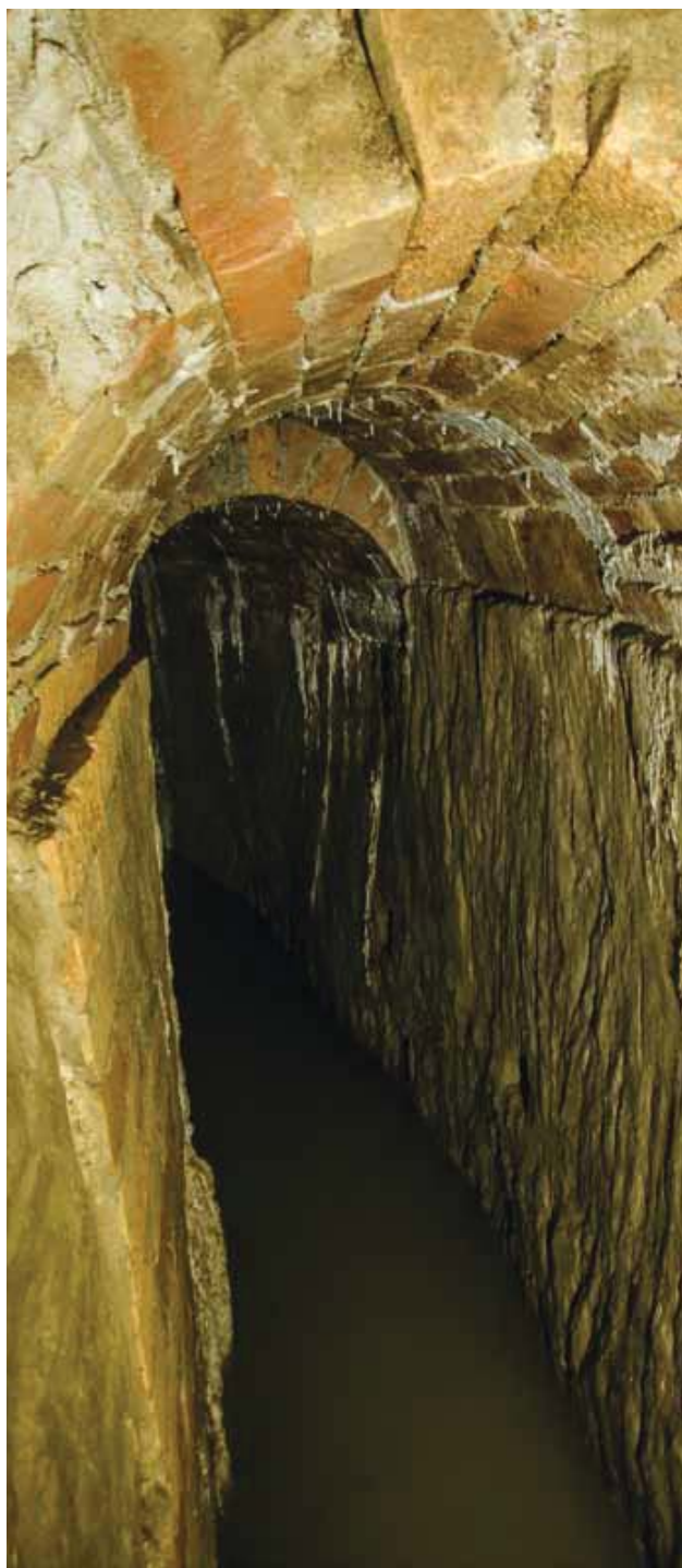
Fig. 3 - Volta in mattoni realizzata fra il 1879 e il 1880 (foto S. Diakatos).
