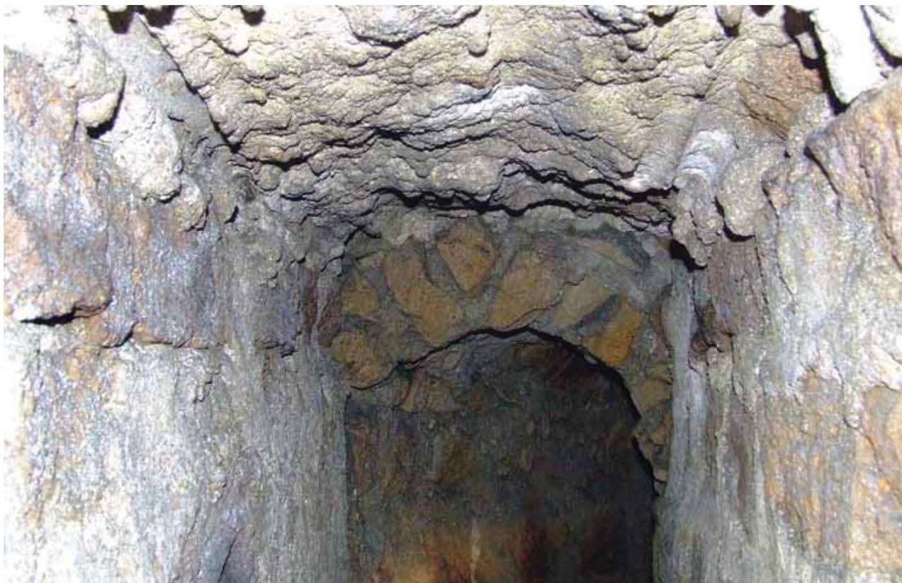
Fig. 6 - Cunicolo dell'acquedotto della Bolla. Dettaglio del rivestimento del soffitto (foto R. Varriale).
