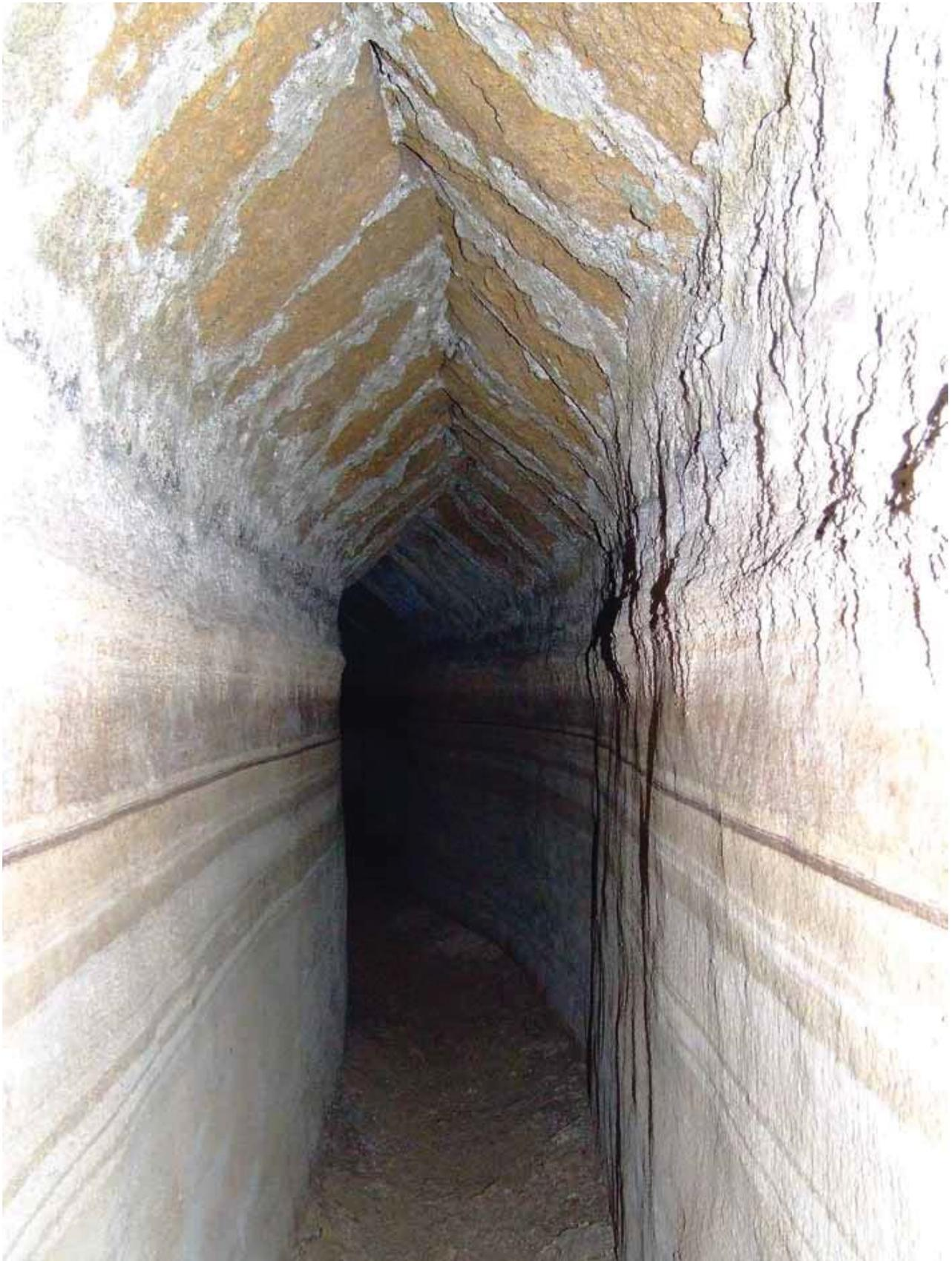
Fig. 7 - Cunicolo dell'acquedotto della Bolla. Dettaglio del soffitto con tecnica a cosiddetta *cappuccina* (foto R. Varriale).
