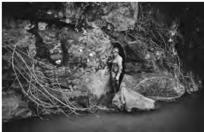
Fig. 16 - Ingresso dei cunicoli CA 269. Si aprono appena sopra il livello medio del torrente Ogliararo, poco a monte di una briglia (foto: C. Germani).
