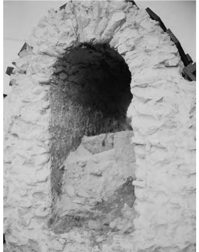
Fig. 13 - Conformazione dello "speco" dell'acquedotto sotterraneo. Nell'immagine si nota l'intonaco impermeabile biancastro spalmato su una delle due pareti verticali e lo strato di riempimento detritico (località Pedaggera, 1990; foto P. Barale).
