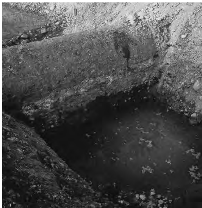
Fig. 7 - Un altro tratto dell'acquedotto sotterraneo fu nuovamente intercettato in località Pedaggera nel settembre del 1989. Al momento del rinvenimento la struttura si presentava in ottimo stato di conservazione (foto P. Barale).
