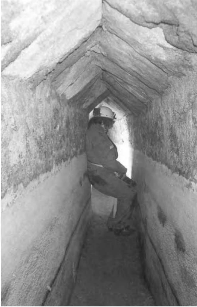
Fig. 9 - Ambito A del rilievo topografico. Dettaglio del soffitto del cunicolo (foto R. Varriale).
