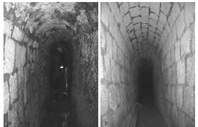
Fig. 6 - Sezioni iniziali dell'acquedotto in cui è visibile un tratto rivestito con opus incertum e pietre squadrate (a) e un tratto rivestito completamente con pietre squadrate (b) di epoca più recente (foto S. Del Prete).
