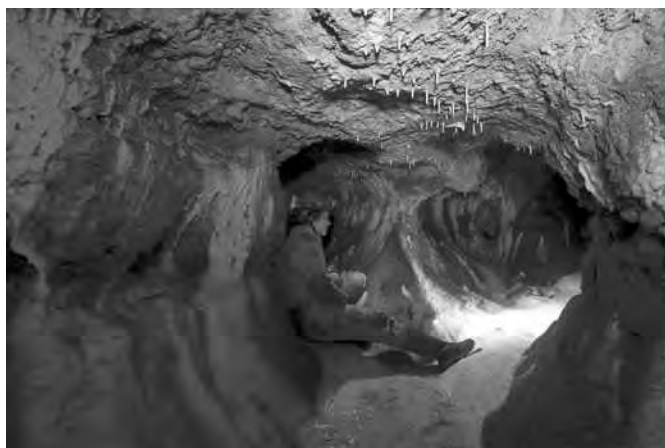
Fig. 13 - Settore finale del ramo di acquedotto scavato nelle ghiaie (foto F. Maurano).
