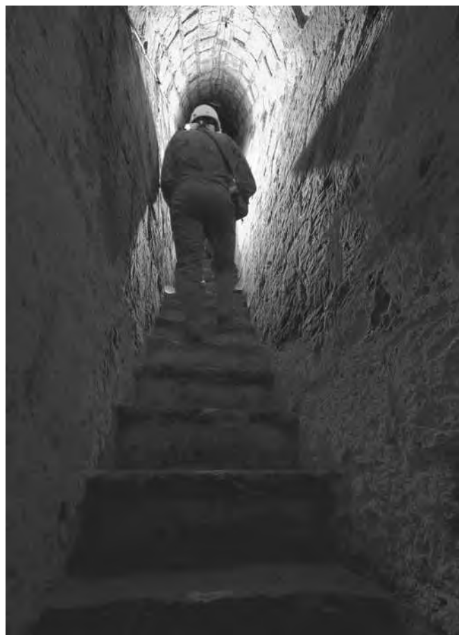
Fig. 8 - La galleria con la scalinata che porta all'esterno (foto F. Maurano).
