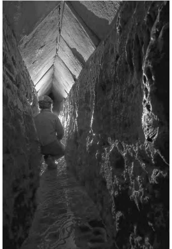
Fig. 12 - Ramo di acquedotto con volta rivestita, con rifacimento a cappuccina (foto F. Maurano).
