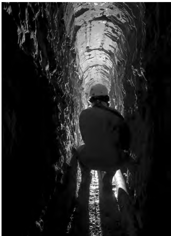
Fig. 7 - Sezione di acquedotto con volta consolidata in calcestruzzo (foto F. Maurano).
