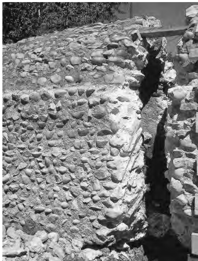
Fig. 8 - Per il necessario passaggio di un canale di scarico, l'acquedotto sotterraneo venne troncato (località Pedaggera, 1990; foto P. Barale).
