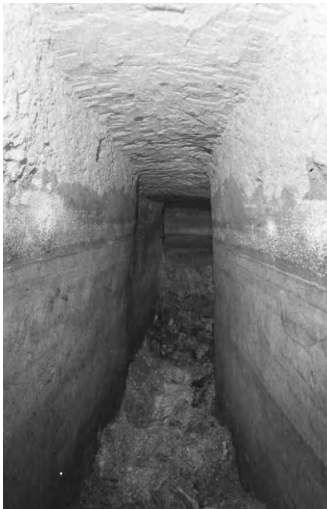
Fig. 16 - Ambito C del rilievo topografico. Dettaglio del cunicolo di accesso alle nuove cavità (foto R. Varriale).
