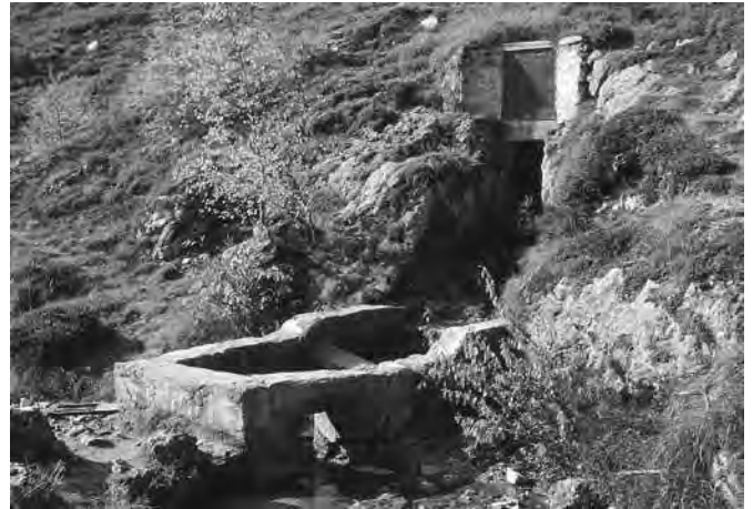
Fig. 2 - La vasca che raccoglie l’acqua del “Pertus”. Fig. 2 - The tank that collects water from the “Pertus”.
