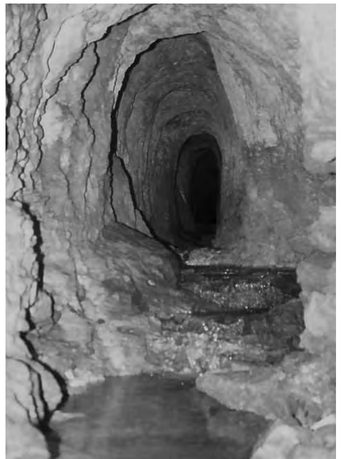
Fig. 6 - Alcune cavità intercettate durante lo scavo all'interno del calcare hanno conferito alle sezioni del tunnel un profilo irregolare.
