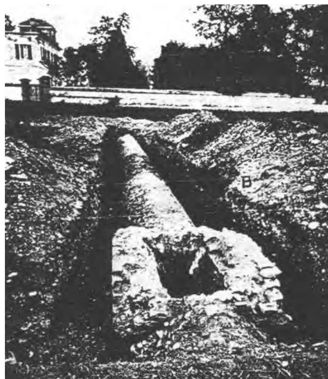
Fig. 5 - Gli scavi del 1936 (da PESCE, 1936), condotti presso la necropoli della "Pedaggera", portarono alla luce un tratto dell'acquedotto sotterraneo (o meridionale) con relativo pozzetto d'ispezione (lumen).
