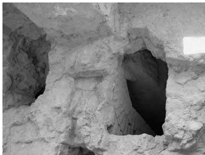
Fig. 4 - Area archeologica di S. Chiara a Napoli. Dettaglio del cunicolo dell’acquedotto romano del Serino con copertura a doppio spiovente (foto R. Varriale).
