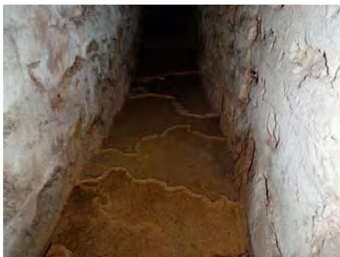
Fig. 23 - Assisi, Rocchicciola. Concrezionamenti a vaschette nel condotto proveniente da Panzo.
