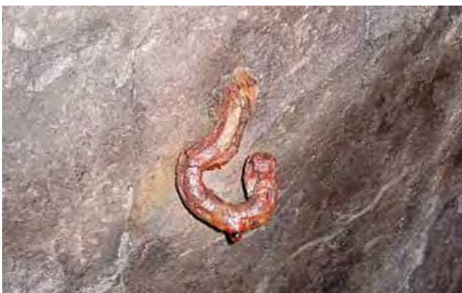
Fig. 12 - Particolare di un gancio di ferro nel soffitto utilizzato per appendere le lucerne a olio (foto A. Ferrario).
