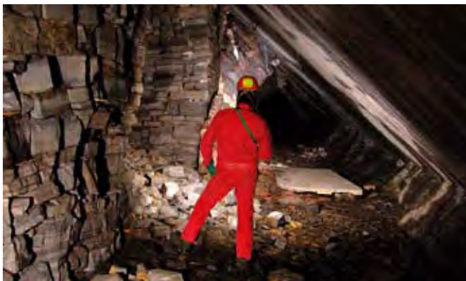
Fig. 8 - Galleria scavata lungo strato (foto A. Ferrario).
