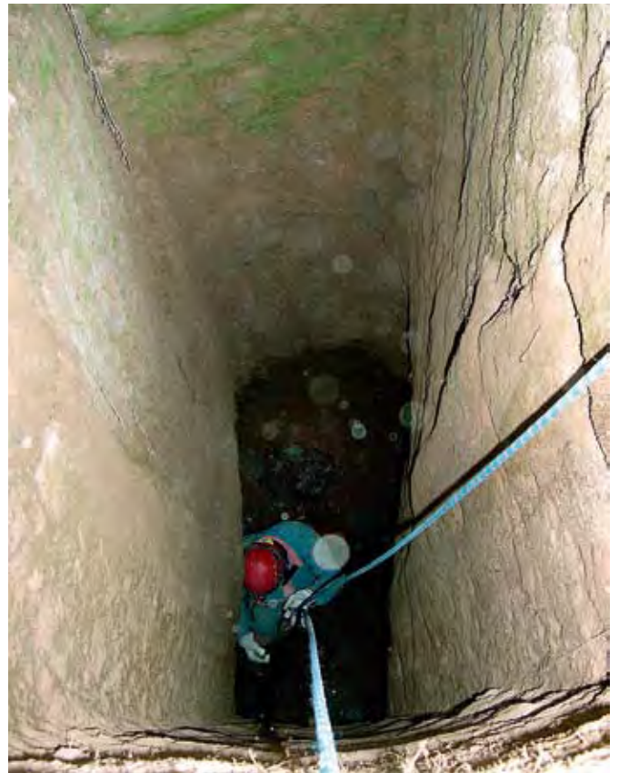
Fig. 11 – Kulaksiz. Uno dei pozzi di accesso alla canalizzazione sotterranea per il trasporto idrico (foto R. Bixio). Fig. 11 - Kulaksiz. One of the shafts to enter the underground canalization used for water transportation (photo R. Bixio).
