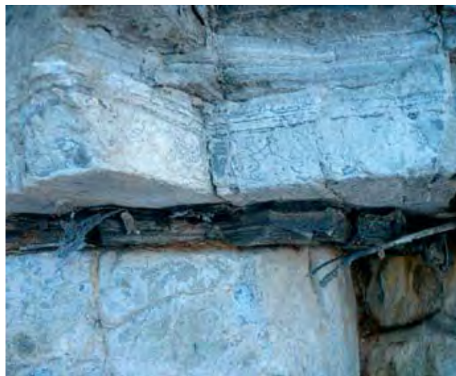
Fig. 2 - Strato di scisto bituminoso intercalato tra strati di dolomia (foto L. Aimar). Fig. 2 - Bituminous shale interlayered between dolomite's strata (photo L. Aimar).
