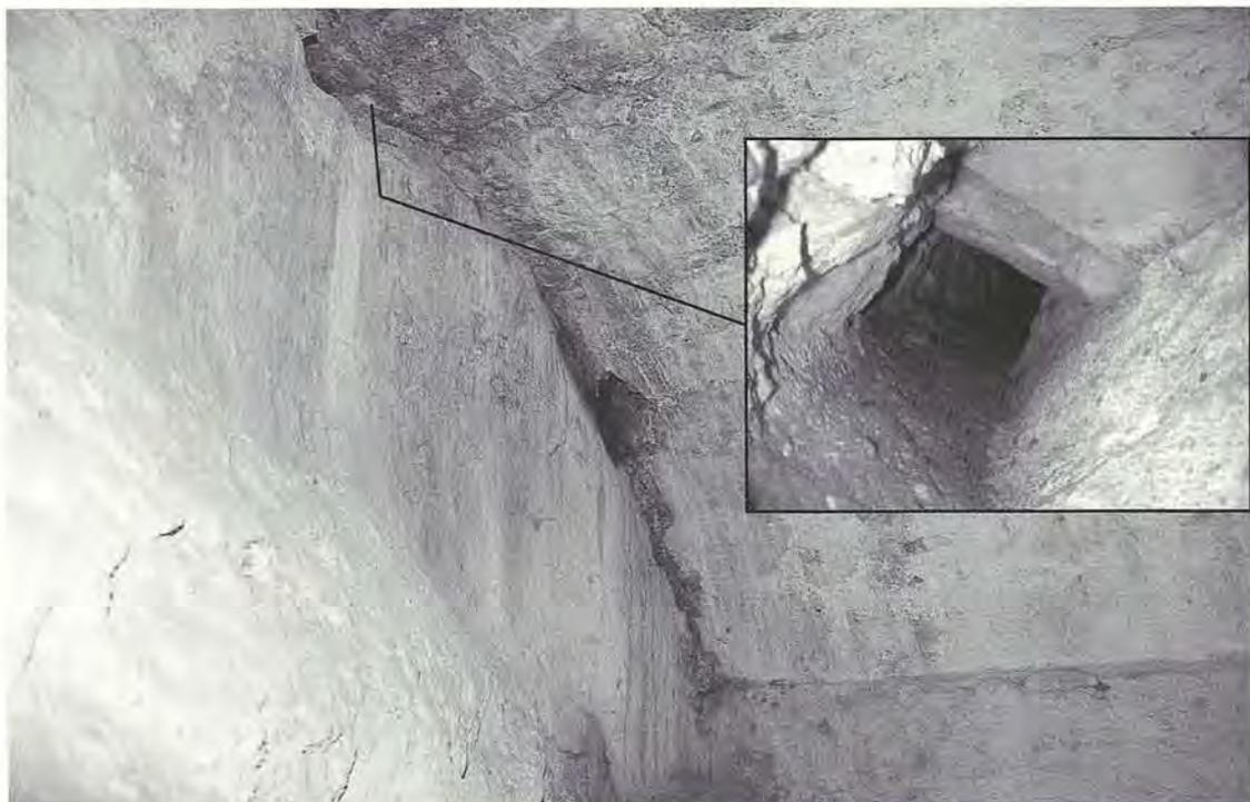
Foto 11: Castello della Pietra - dettaglio della cisterna centrale, si possono notare due sbocchi delle condutture che alimentavano la cisterna. Nel riquadro: immagine endoscopica dell'interno della condotta in alto a sinistra (foto di Antonella Pasquale e Daniele Massazza).
