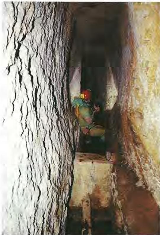
Foto 1: sbarramento in mattoni pressati con intonaco cementizio, con conseguente intubamento delle acque di falda in tubi di ghisa (foto degli Autori).
