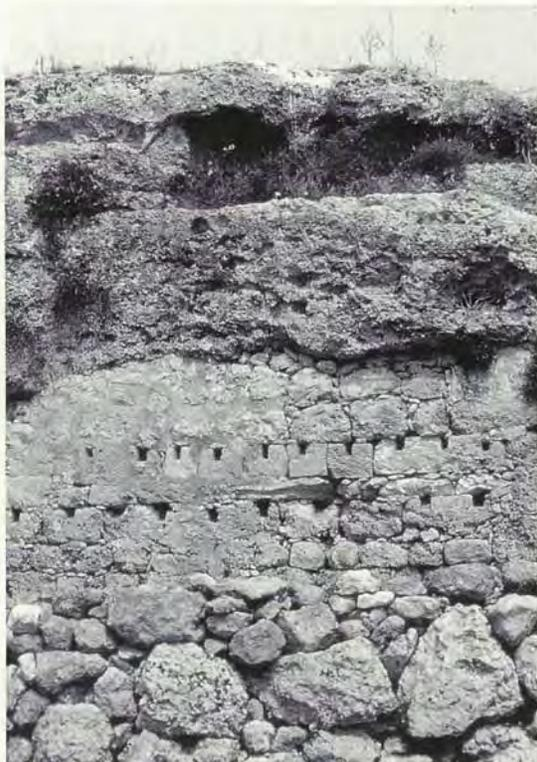
Foto 10 (destra): apiario intermedio di Imgiebah. Risulta evidente il profilo della grotta naturale tamponato da un muro, in gran parte costruito a secco. Nei conci sono scavati i "fori di volo" sul retro dei quali erano poste le arnie (foto R. Bixio).
