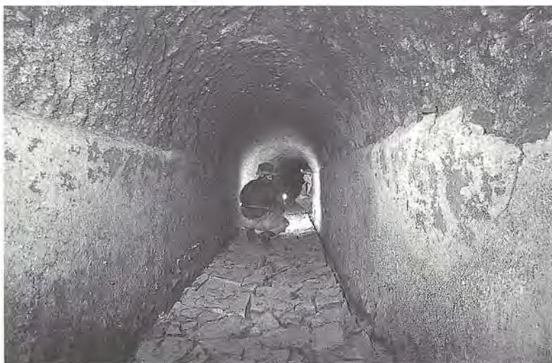
Foto 2: galleria nella zona più interna dell'ipogeo. Sul fondo si può notare lo spesso strato di fango disseccato, sulle pareti l'intonaco impermeabile (foto C. Germani).
