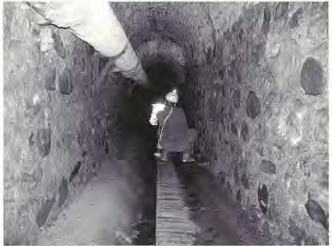
Foto 7: galleria di drenaggio del torrente stagionale deviato in seguito alla costruzione della Ghiacciaia di Piantelli (foto A. Verrini).
