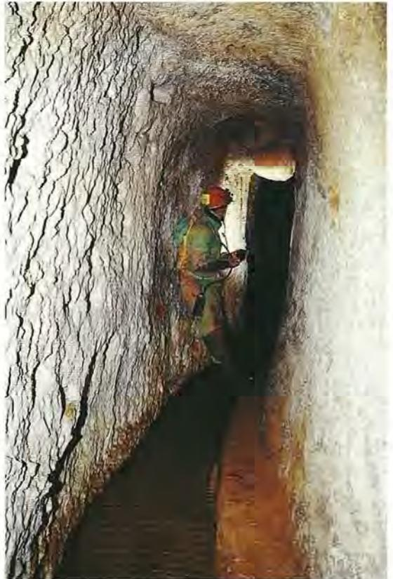
Foto 3: galleria interamente scavata nella calcarenite, con scorrimento di acque sul piano di calpestio (foto degli Autori).
