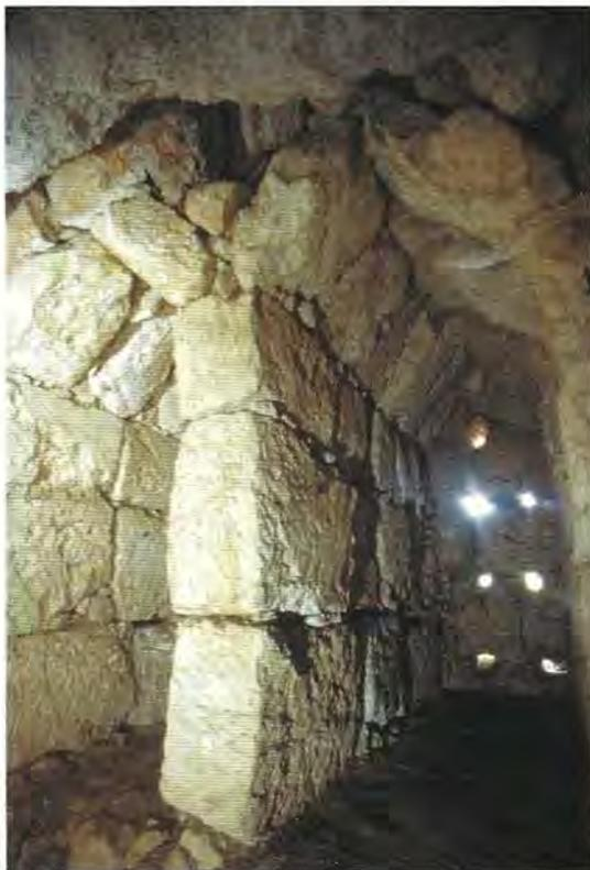
Foto 7: la volta delle nicchie è costituita da lastre contrapposte a doppio spiovente oppure da architravi monolitici. In controluce si notano i fori di volo a cui, in origine, corrispondevano altrettante arnie (foto M. Traverso).
