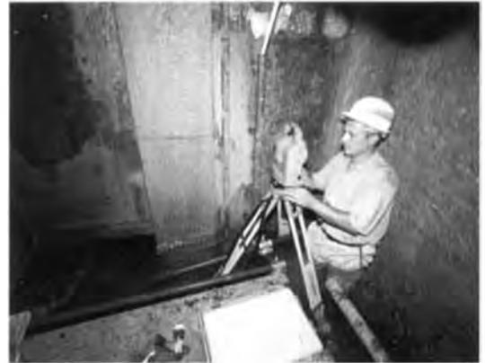
Foto 4: Rilievo interno: installazione della stazione celerimetrica (foto G. Badino).
