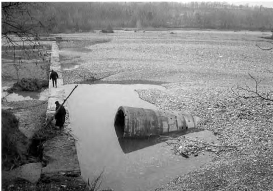
Foto 14: Il greto del Trebbia dopo le alluvioni del novembre 2000 - in primo piano la briglia sotto la quale si trova il traversante ed una delle torri in cemento, completamente divelte (foto M. Chiesi).
