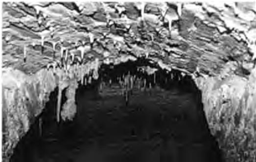
Foto 3: Particolare della volta concrezionata che ricopre la cisterna (Foto M. Kraus).
